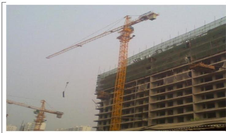
**Figure X.14 Montage de la grue (l'engin de levage)**
