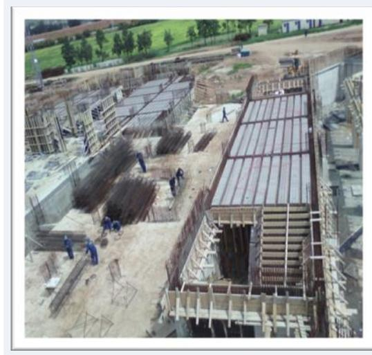
**Figure X.7 Ferrailage de plancher**
