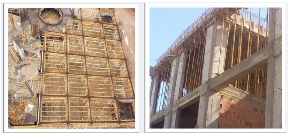
**Figure X.6 Coffrage de plancher**
