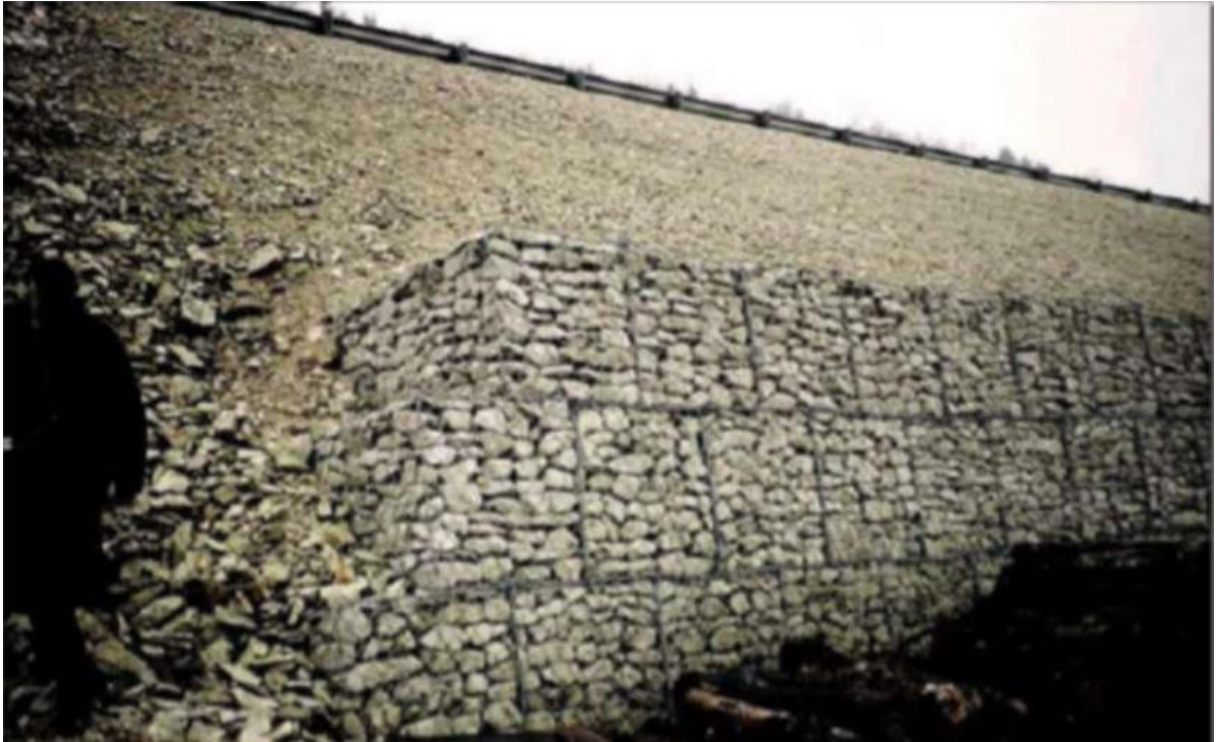
Figure IV-13- Exemple d' ouvrage souple : Mur en gabion (Service d' Etude Technique des Routes et Autoroutes (SETRA))
