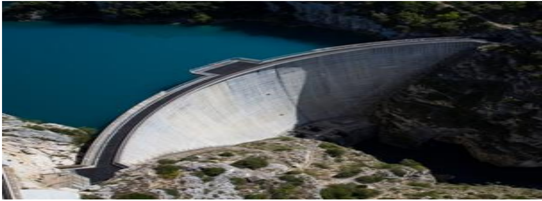
Figure (I.3) : un barrage
