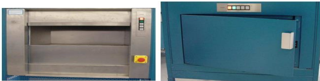
Fig .1.9 Les deux types des portes palières.
