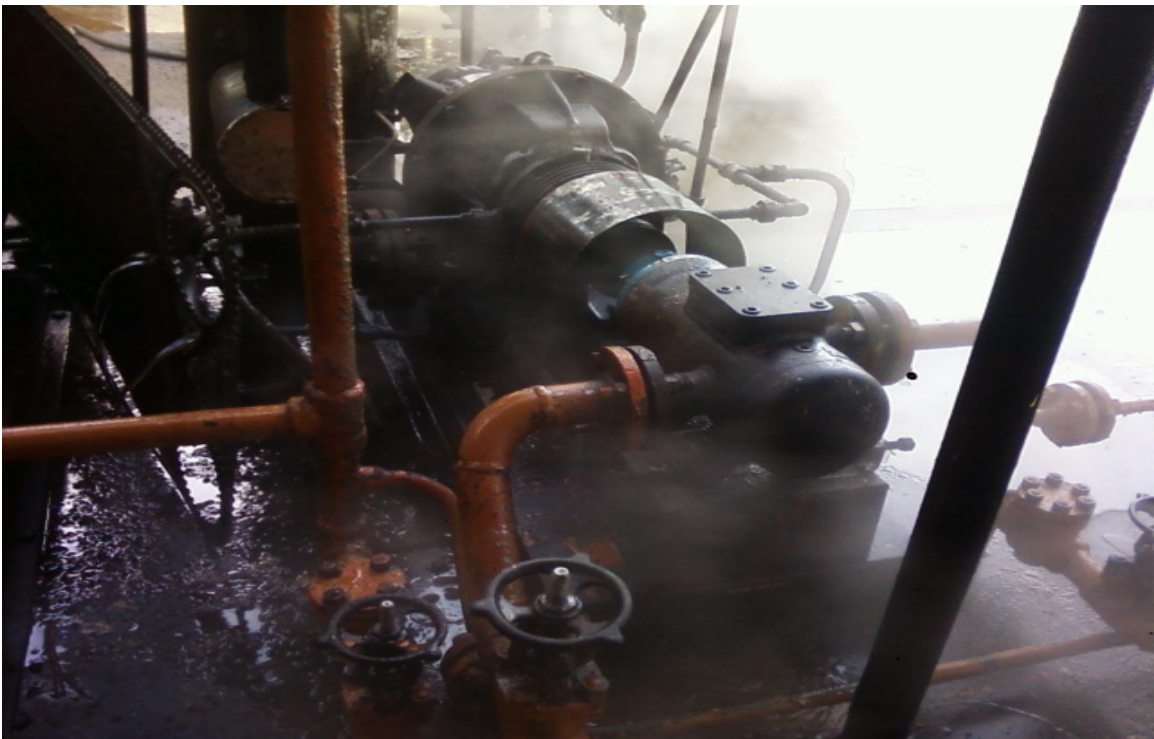
FIGURE.27 : Turbo pompe d'huile d'étanchéité [04]
