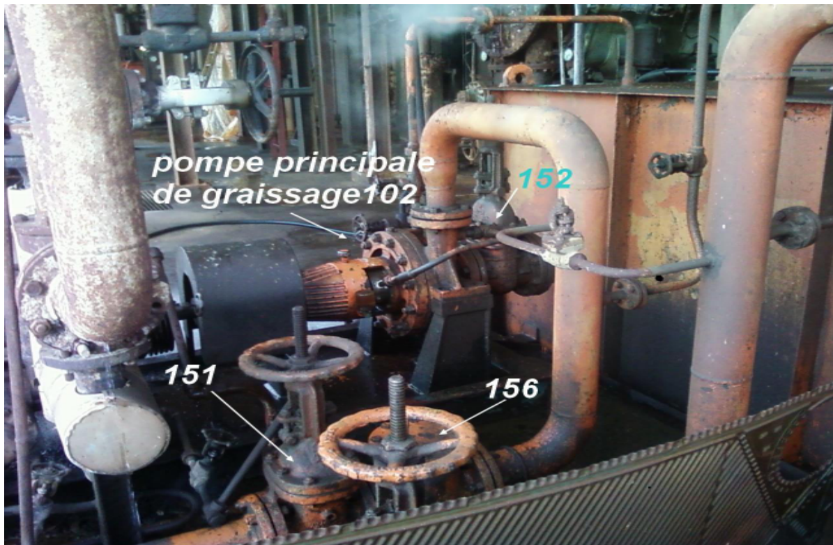
FIGURE 22 : Pompe principale de graissage [04]
