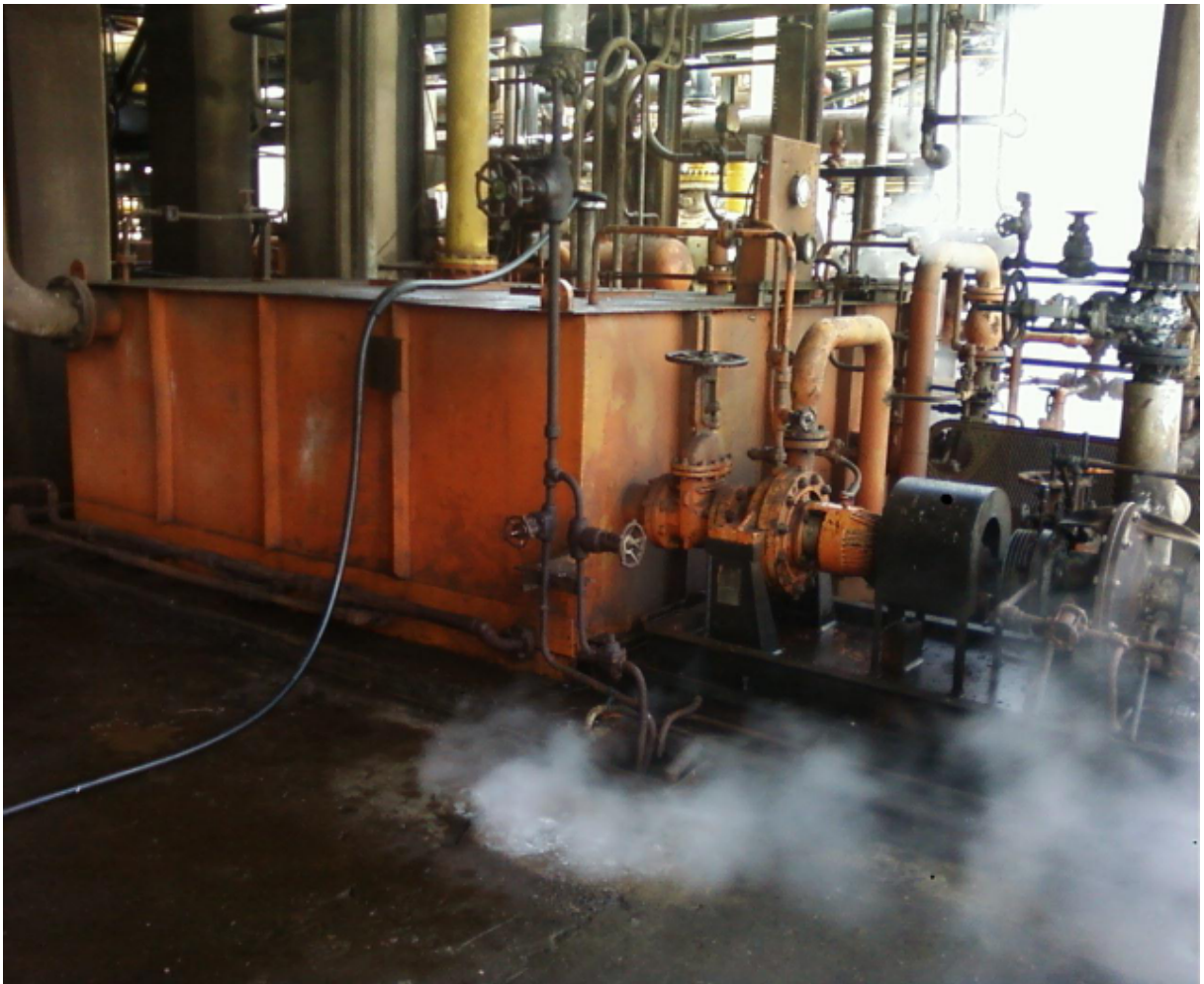
FIGURE 21 : Réservoir d'huile de graissage [04]
