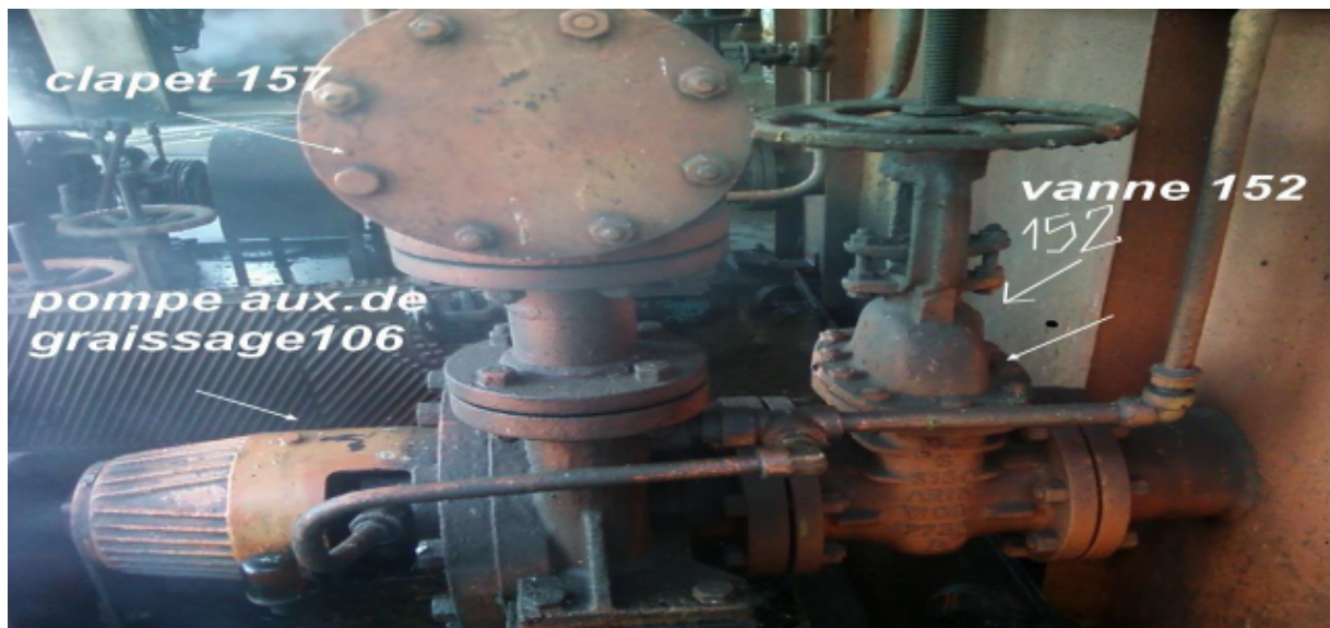
FIGURE 23 : Pompe auxiliaire de graissage [04]
