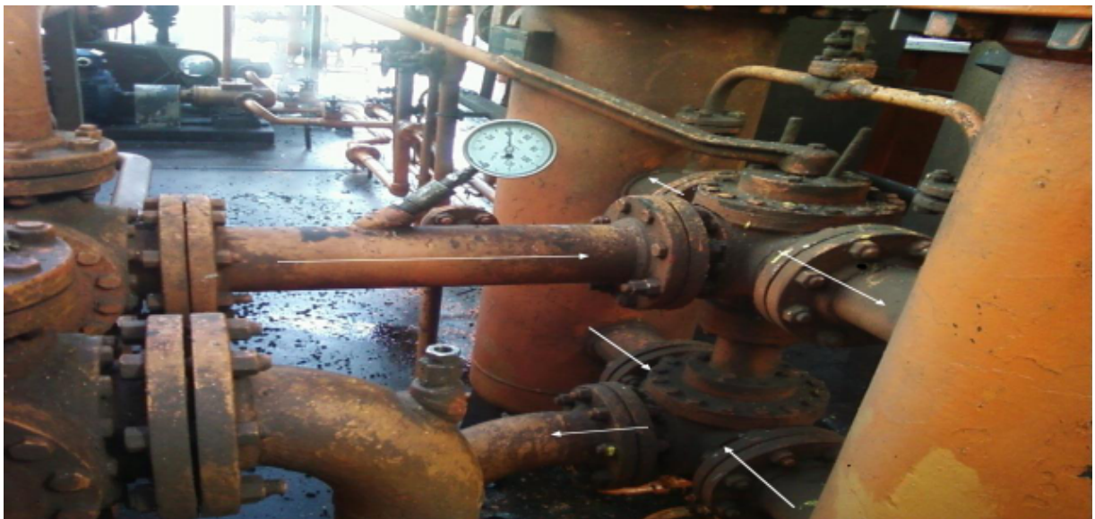
FIGURE 25 : Mano mètre pour mesurer la pression au niveau de la pompe de graissage [04]
