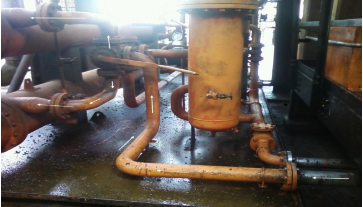
FIGURE 24 : Réfrigérants d'huile de graissage [04]
