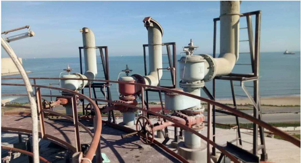
Figure 3. 12.les soupapes de sécurité
