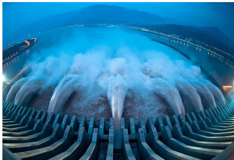
Fig-1- 3 centrale hydraulique
