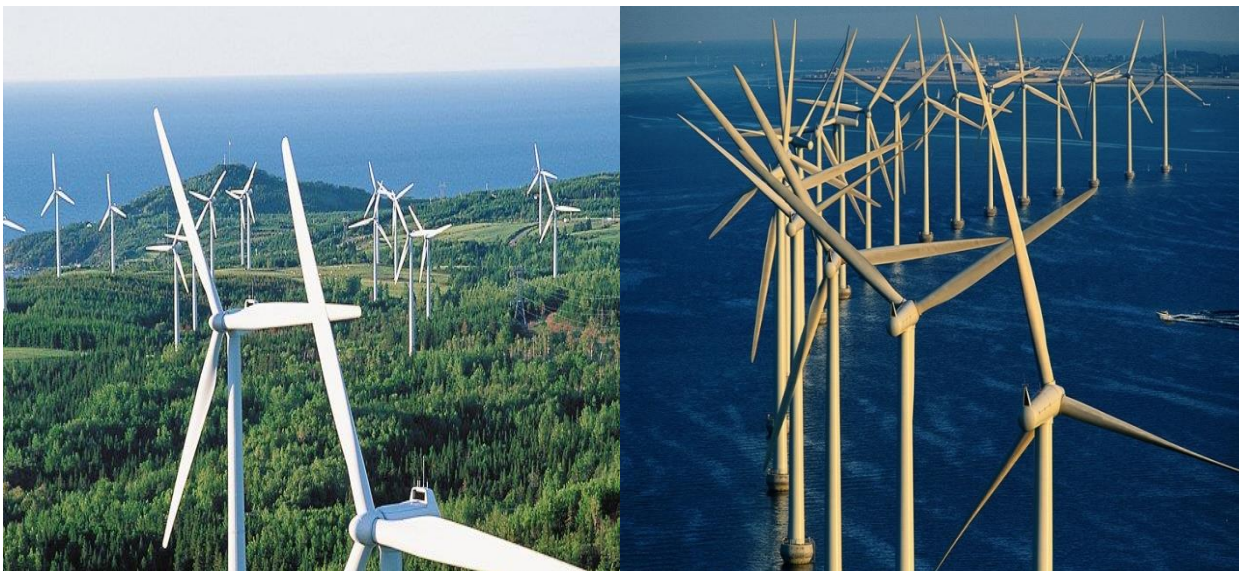
Fig-1- 8 éolien on shore et offshore
