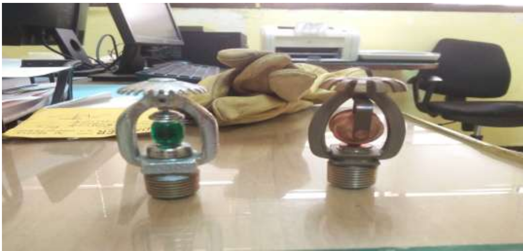
Fig. II.17. Tête de sprinklers
