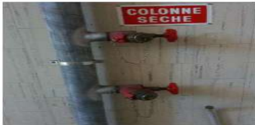
Fig.II.07.Colonne sèche[FOR].
