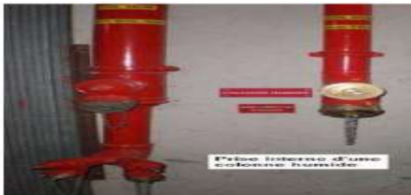
Fig.II.08. Colonne humide [MA-].
