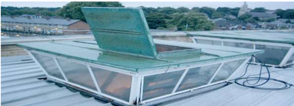
Fig. II.21. Système mécanique de désenfumage [GRO].
