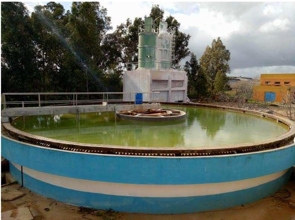
Figure II.5 : Décanteur
