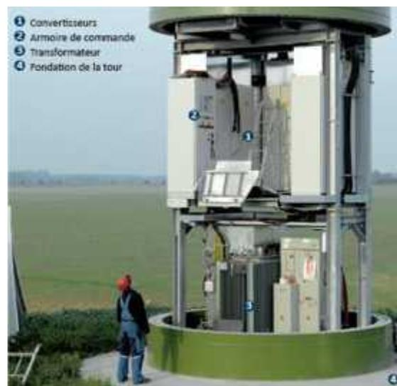
**Figure 2.6.** Système de contrôle-commande.
