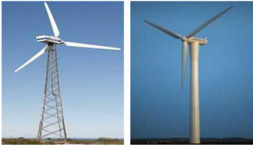
*Figure 2.9.* Eoliennes à tour en treillis et à tour tubulaire.
