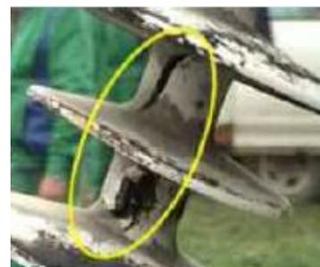
Figure 3.9:Exemple de détérioration d'un isolateur de ligne par l'effet corona
