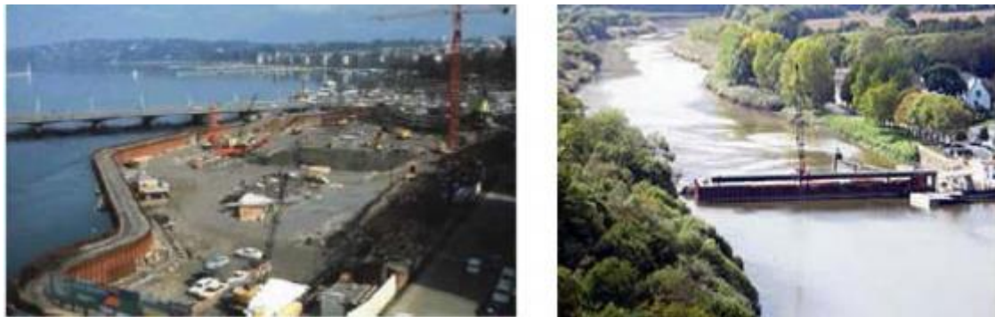
Figure I.15. L'utilisation des palplanches comme batardeaux en rivière en France
