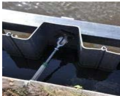
Figure I.10 Palplanches laminées à froid.[8]
