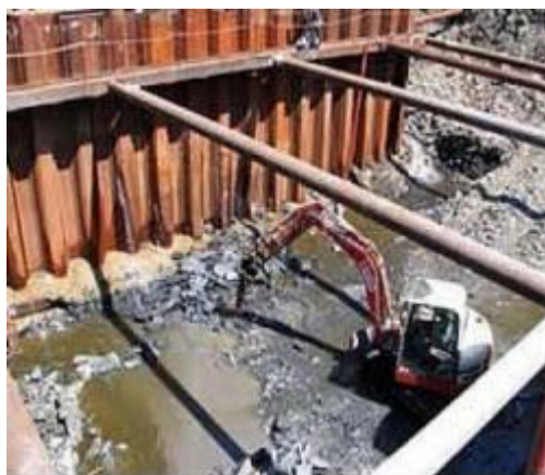
Figure I.16. Terrassement dans le batardeau
