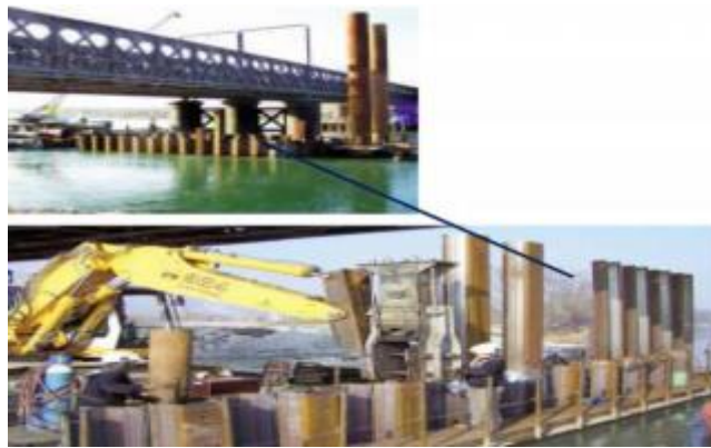
Figure I.18 Chantier d'une reconstruction d'un pont en utilisant des palplanches métalliques
