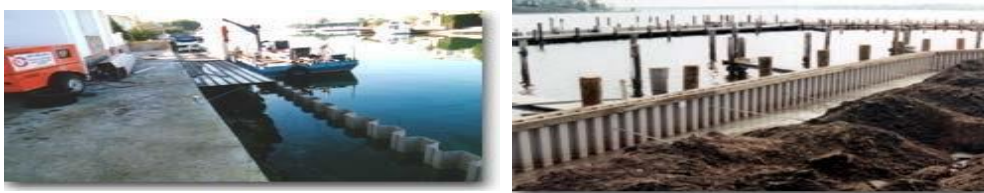
Figure I.09 Palplanche en PVC.
