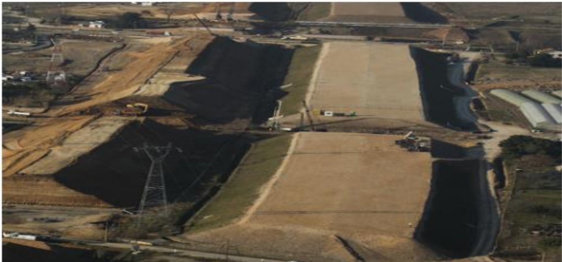
Figure 1.3 : Remblai de grande hauteur
