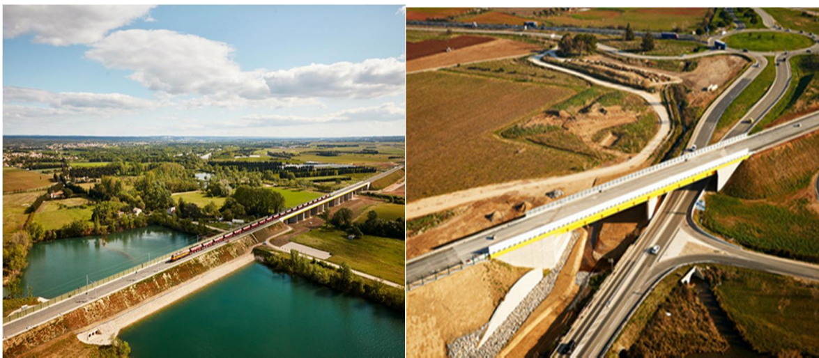
Figure 1. 1 : Types de Remblai (ferroviaire, routier)
