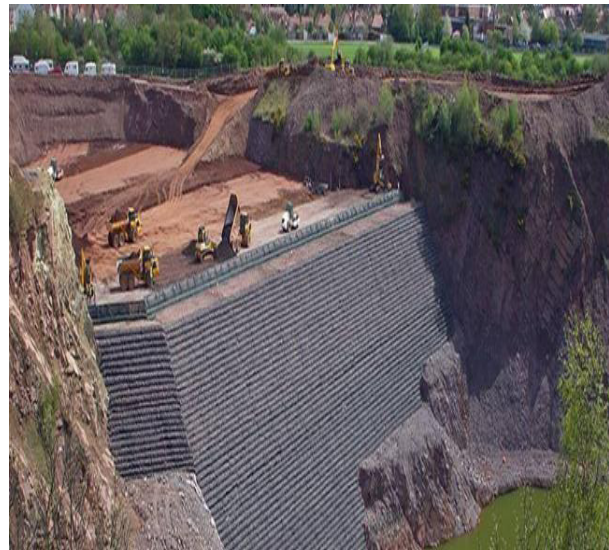
Figure I-19-19' : Chantier en cours de réalisation utilisant la technique géotextile. [18]
