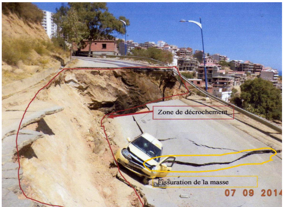
Figure II-3 : Vue sur le coté du glissement (décrochement de la masse rocheuse)
