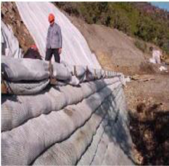
Figure I-19-19' : Chantier en cours de réalisation utilisant la technique géotextile. [18]
