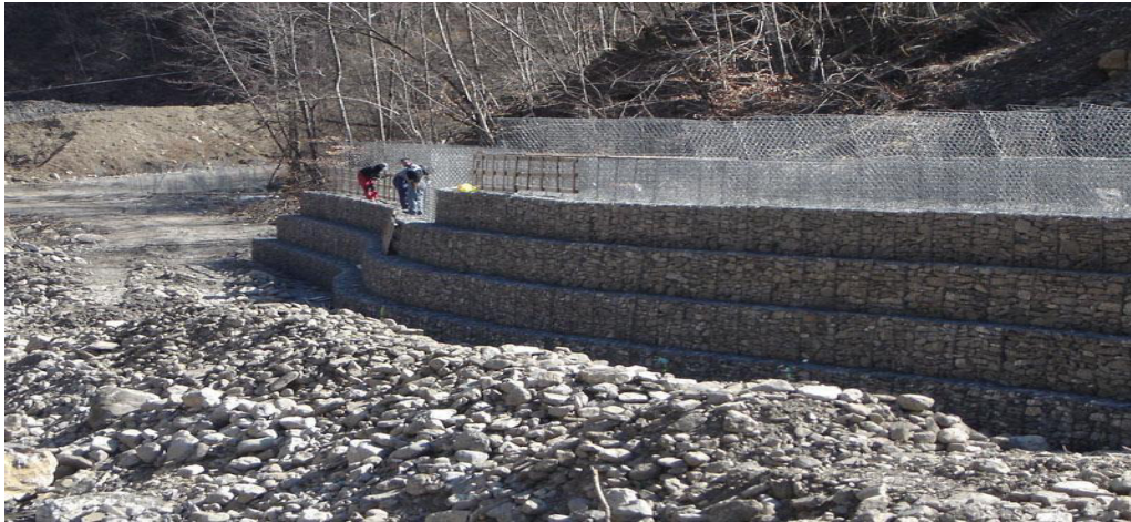
Figure I-18 : Réalisation d'un mur en gabion. [19]
