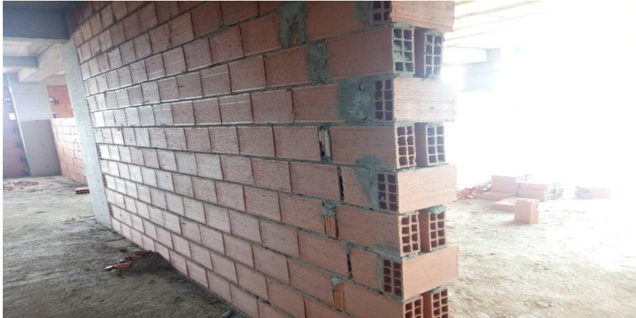
Figure IV-01 : Mur en maçonnerie
