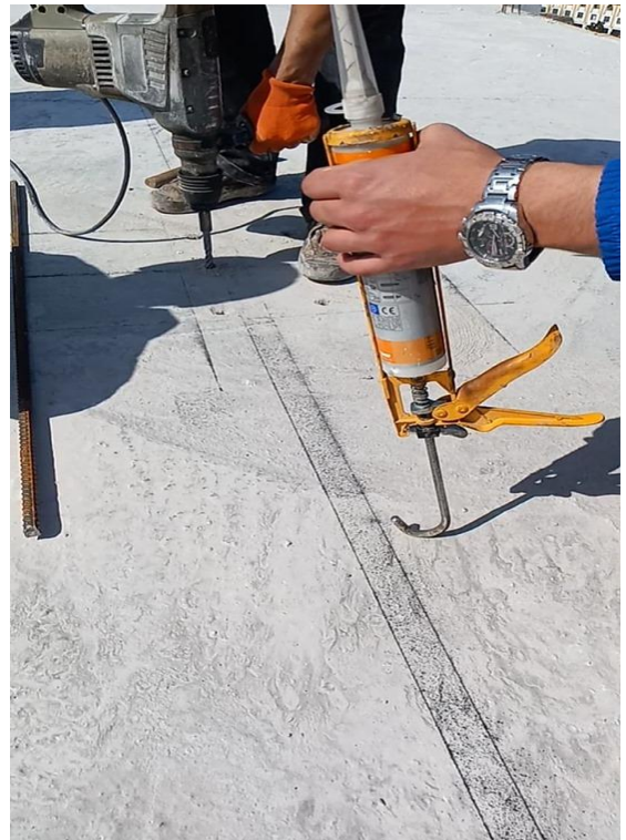
Figure III-02.03 : pressage des trous diamètre 18
