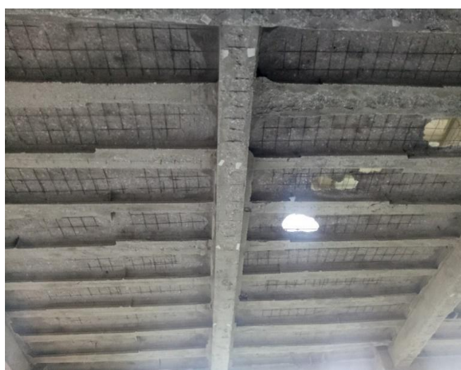
Figure II- 19-20 : Plancher nervurer qui a été toucher par l'incendie avant et après sablage
