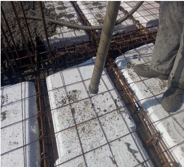
Figure I-29-30 : vibration lors le coulage d'un plancher corp creux
