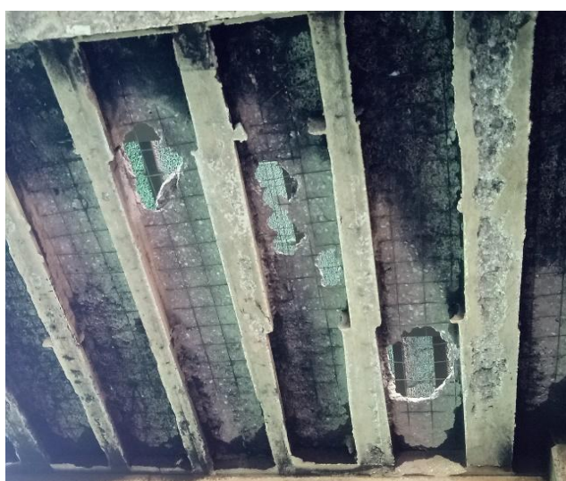
Figure II- 19-20 : Plancher nervurer qui a été toucher par l'incendie avant et après sablage
