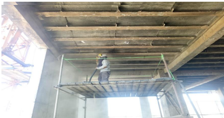
Figure II- 10 Le début de sablage par deux Manoeuvre utilisant une sableuse a haute pression
