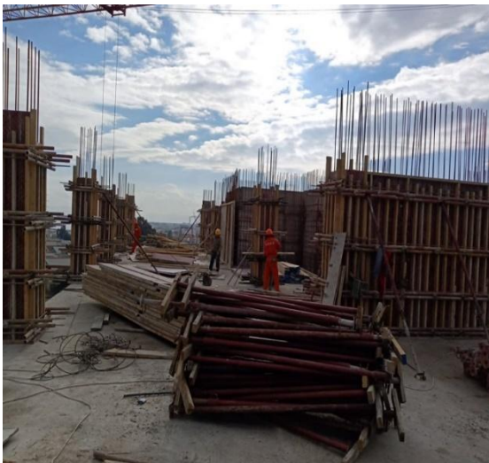
Figure I-12-13 : Coffrage des voiles et des poteaux
