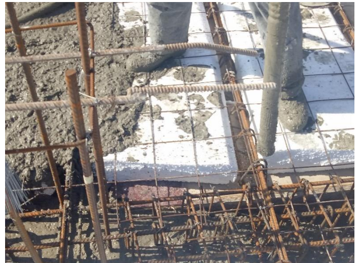
Figure I-29-30 : vibration lors le coulage d'un plancher corp creux
