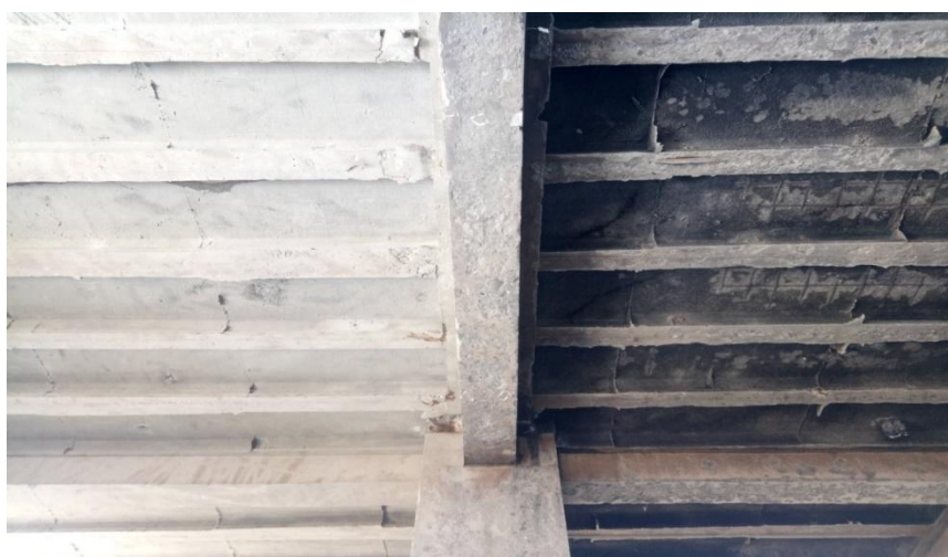
Figure II- 21-22-23 : Quelque plancher a corp creux avant et après le sablage
