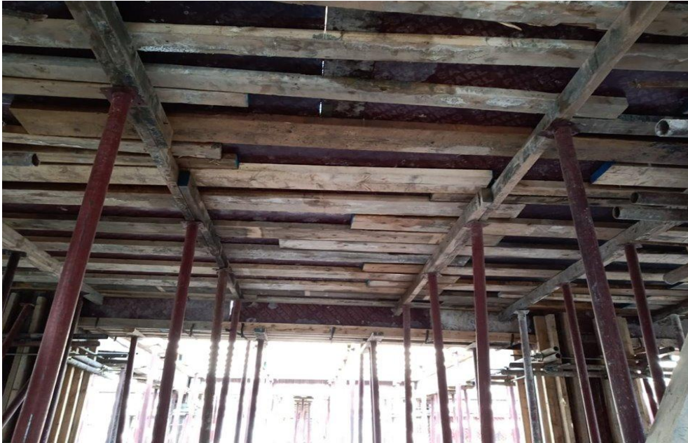
Figure I-14 : coffrage d'une dalle pleine
