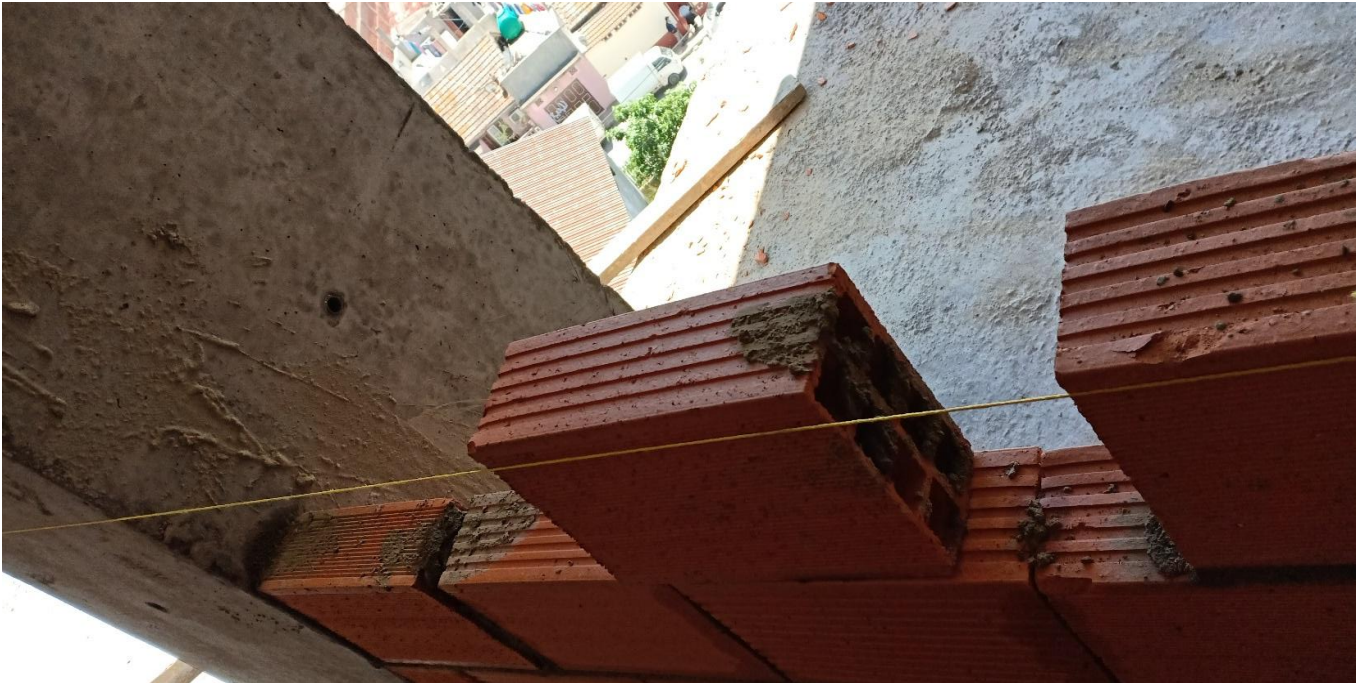
Figure IV-06 : construction d'un mur avec le cordeau
