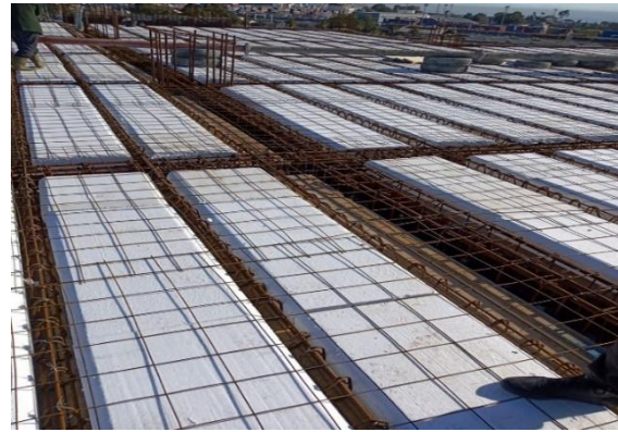
Figure I- 20-21 : ferrailages des poutrelles
