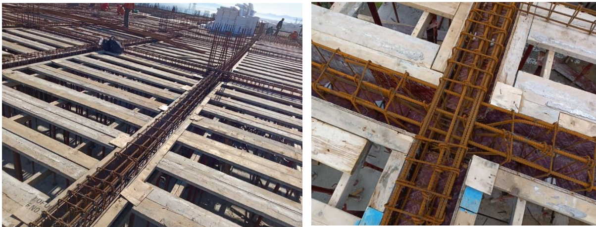
Figure I- 16-17 : ferrillage d'une poutre
