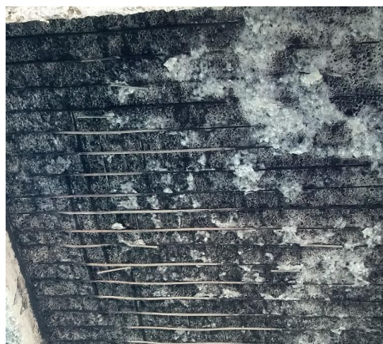
Figure II- 26-27-28 : Une dalle pleine avant et après le sablage
