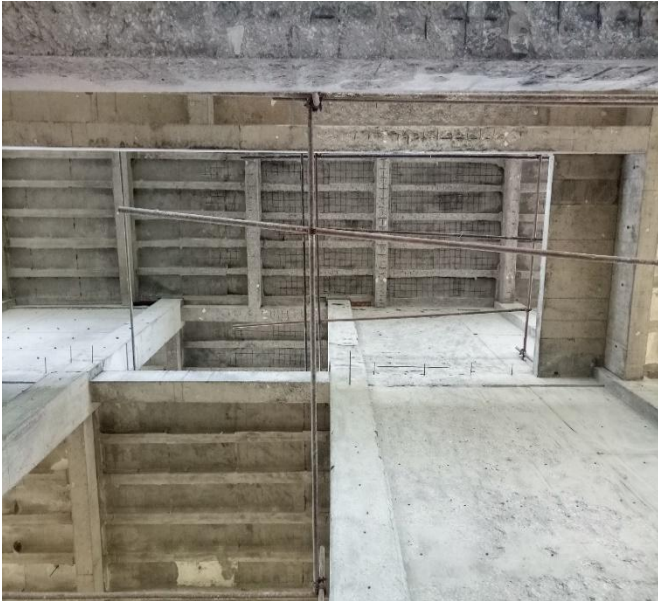
Figure II- 24-25 : Les 2 niveau supérieure avant et après le sablage
