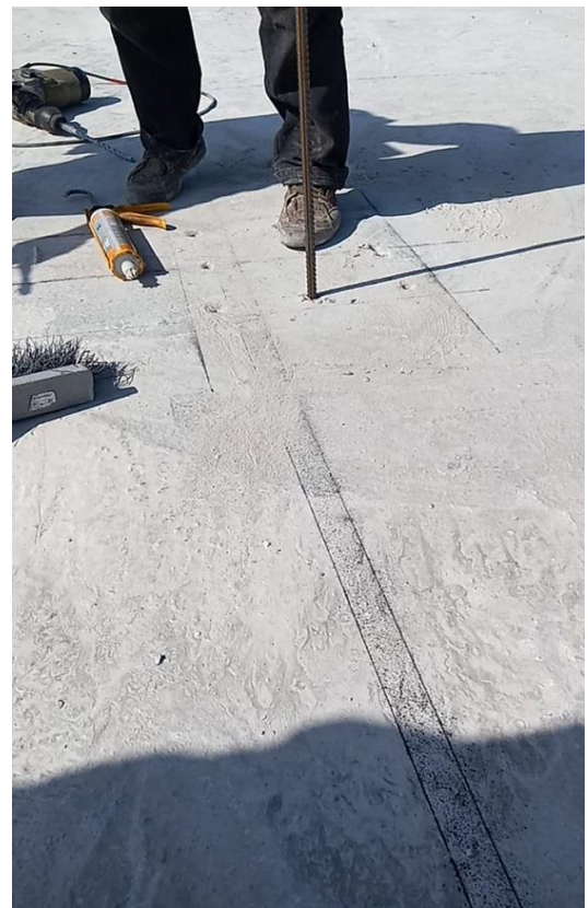
Figure III-05 : mise en place de ferraille
