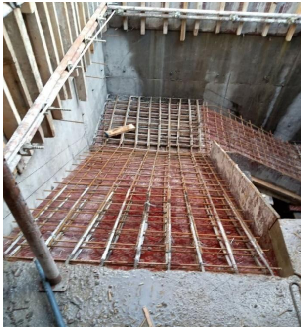
Figure I- 24 : ferrailages escaliers
