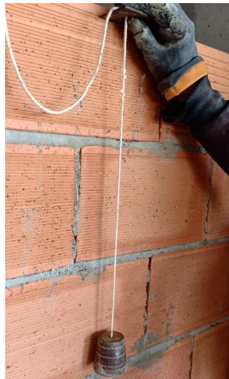
Figure IV-07.08 : vérification de la planéité et de la verticalité des parois
