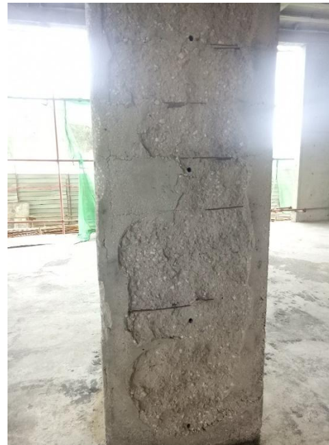
Figure II- 14-15 : Un poteau qui a été touché par l'incendie avant et après le sablage
