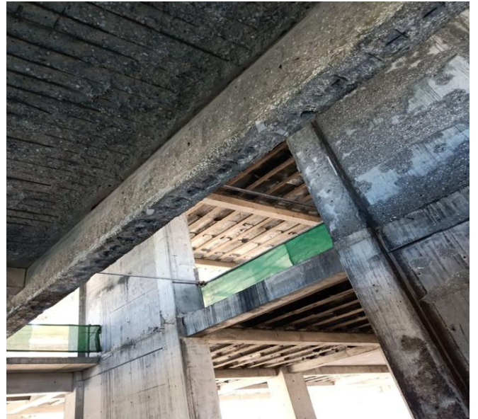
Figure II- 24-25 : Les 2 niveau supérieure avant et après le sablage
