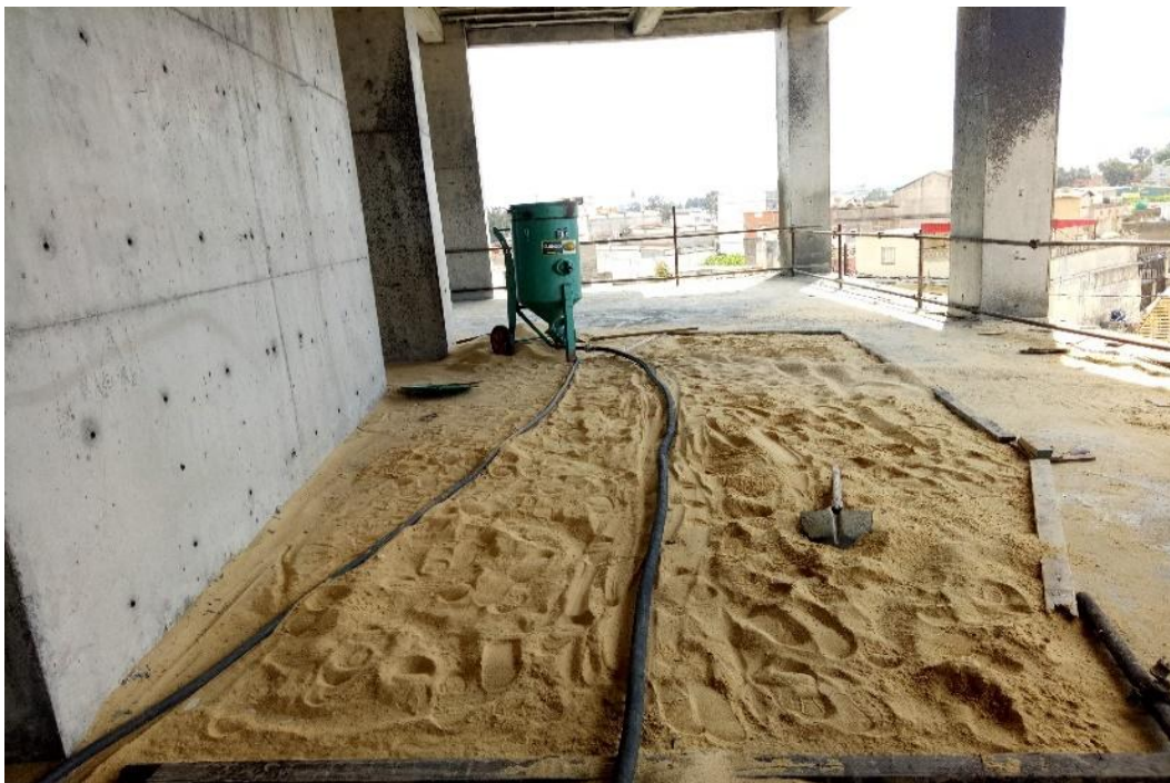
Figure II- 12 Le séchage de sable humide pour l'utiliser dans le sablage
