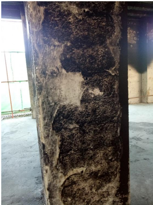
Figure II- 14-15 : Un poteau qui a été touché par l'incendie avant et après le sablage
