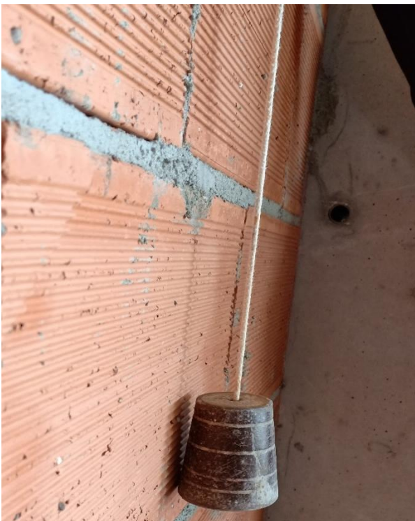
Figure IV-07.08 : vérification de la planéité et de la verticalité des parois
