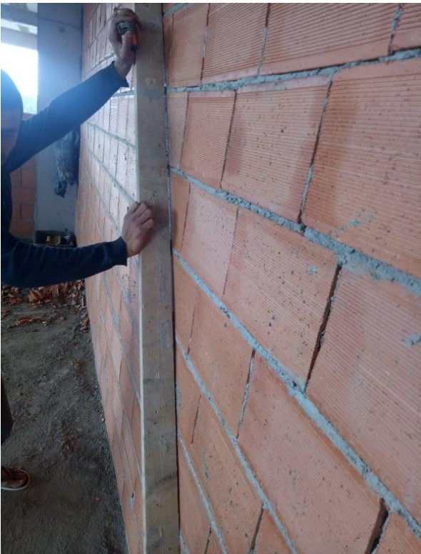
Figure IV-09.10 : vérification de la planéité de Mur en maçonnerie
