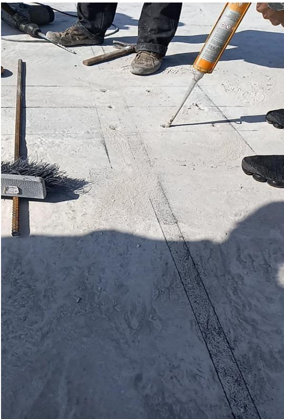
Figure III-04 : injection de produit chimique
