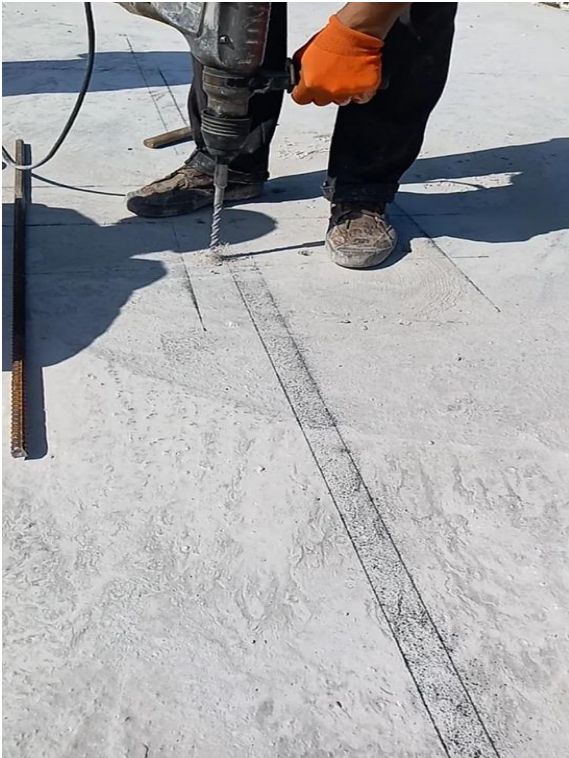
Figure III-02.03 : pressage des trous diamètre 18
