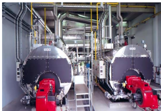
Figure 4 : Chaudière industrielle
