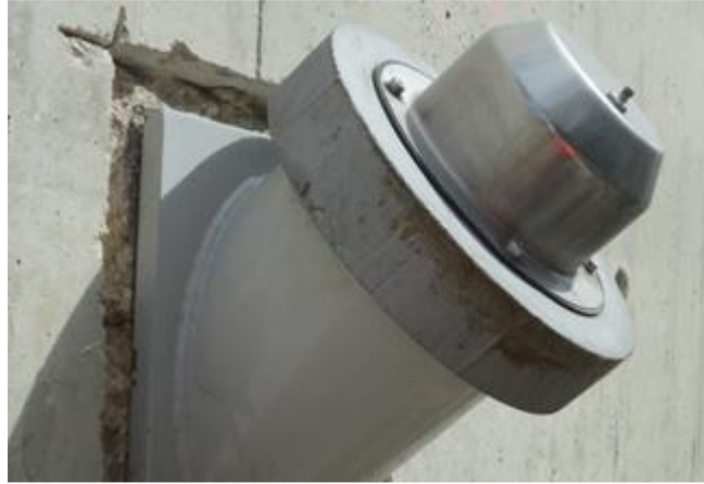
Figure3.18 : image de la tête d'ancrage
