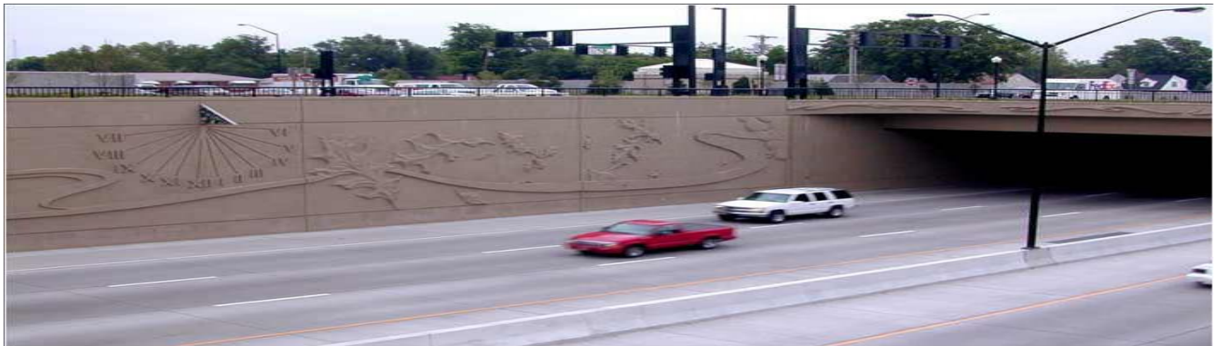
Photo de murs de soutènement
