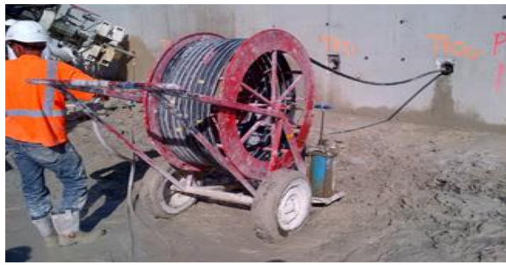
Figure3.15 : image de la mise en place d'ancrage
