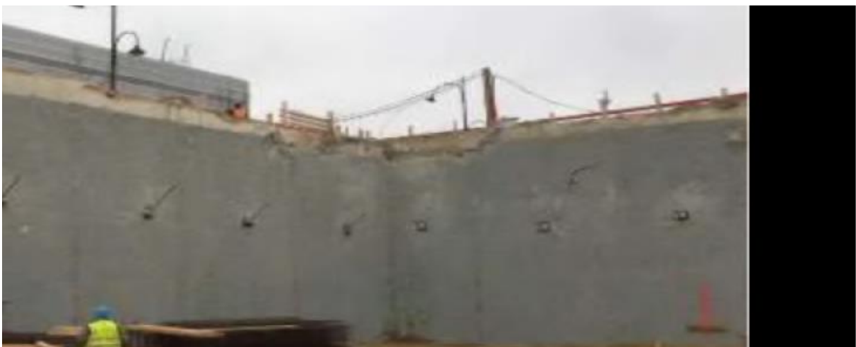
Figure2.1 Photo de la paroi moulée
