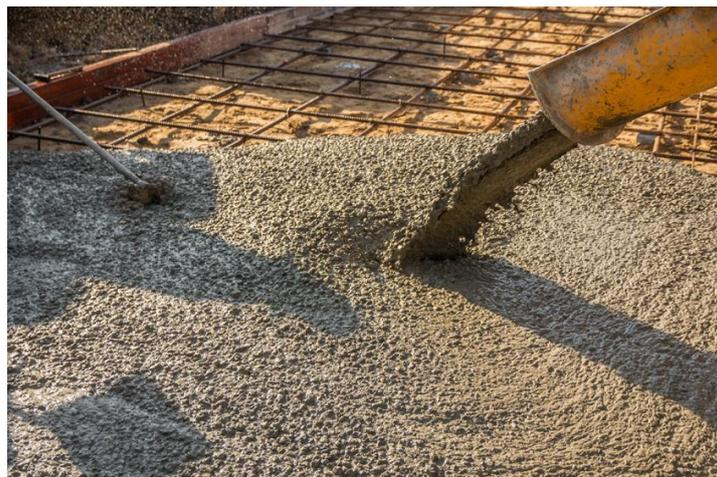
**Figure (I-1) : Coulage d'un béton autoplaçant**
