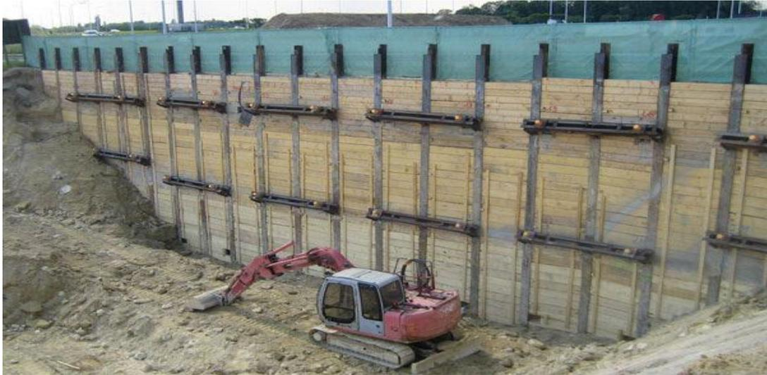
Figure 2.8 Travaux de réalisation des parois berlinoise
