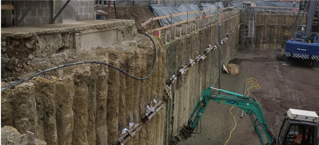
**Figure 2.26 Travaux de réalisation des parois soilmix en pieux**
