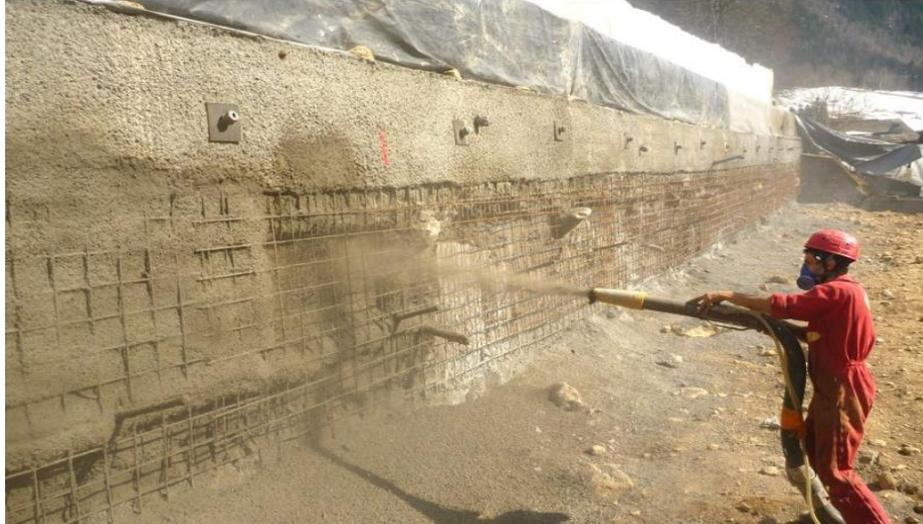
Figure 2.20 Travaux de réalisation des parois clouées
