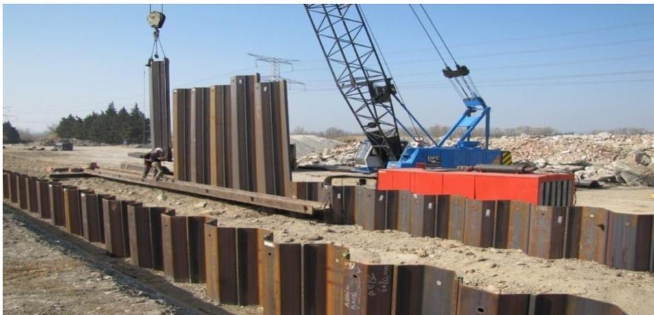
**Figure 2.14 : travaux de réalisation des palplanches**
