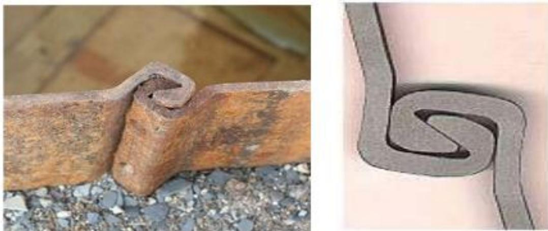
**Figure 2.17 Serrure à la jonction de deux palplanches.**
