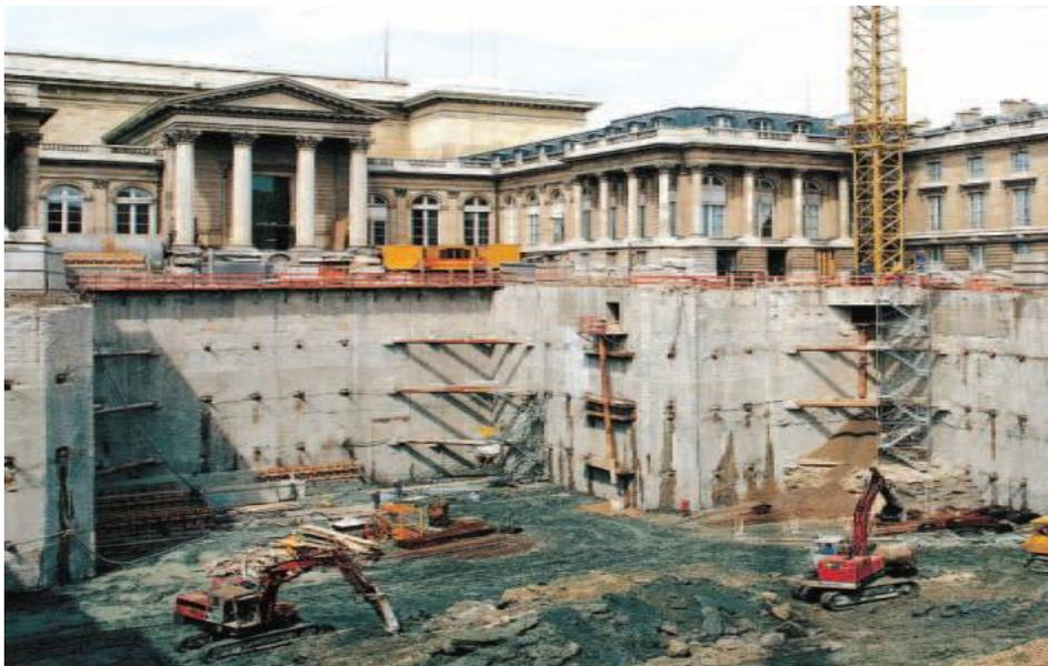
**Figure 1.3 Exemple d'une fouille profonde, contre un bâtiment historique, sous le niveau phréatique, à l'abri d'une paroi combinant des tirants précontraints et des butons d'angle.**
