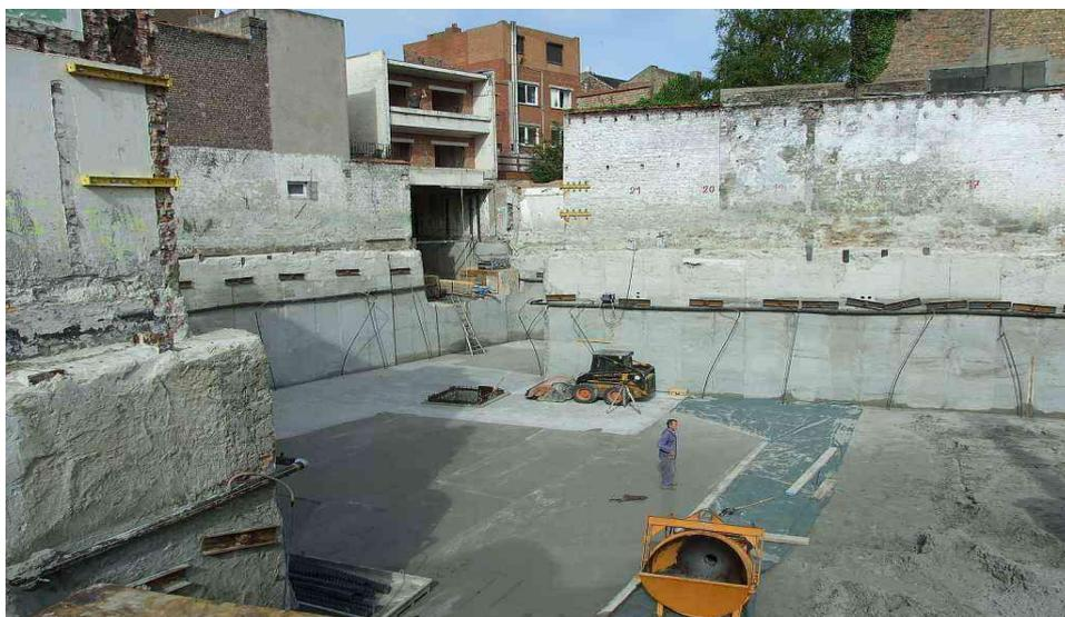
Figure 2.29 Travaux de réalisation des parois soilmix en panneaux
