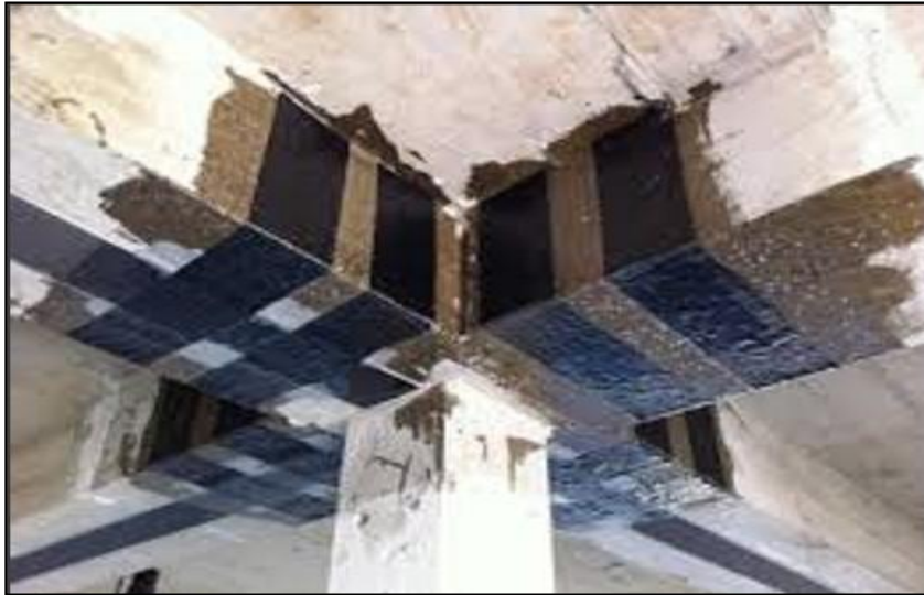
Figure I.16- Renforcement des poutres par matériaux composites
