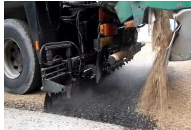
Figure III.16 : Enduit superficiel
