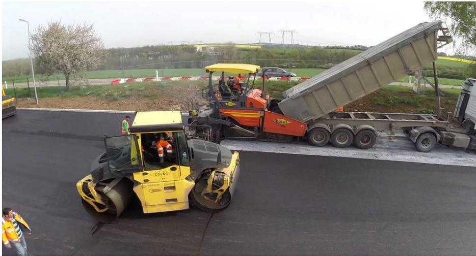
**Figure III.17 : Bêton bitumineux**
