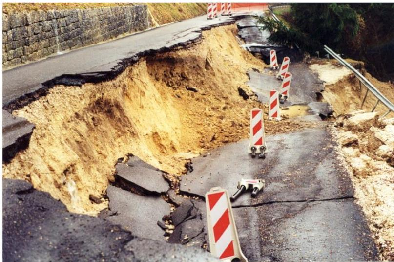
**Figure 1.40** : Glissement d'une chaussée
