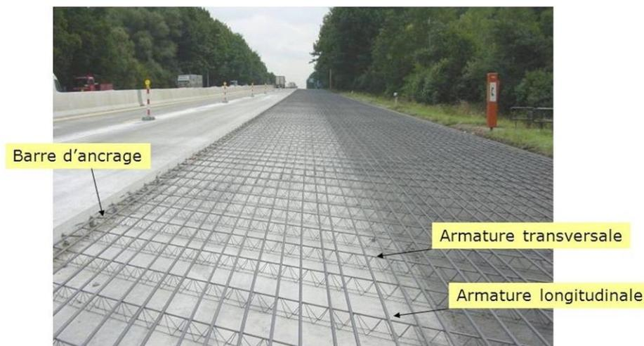
**Figure I.20 :** Chaussée en béton de ciment
