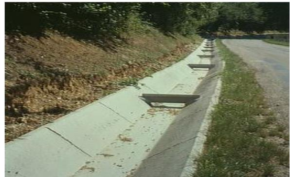
**Figure I.13 : Fossé en béton**
