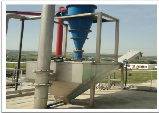
Figure 12 Classificateur à sable
