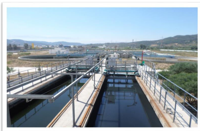
Figure 11 Dessablage –Déshuilage
