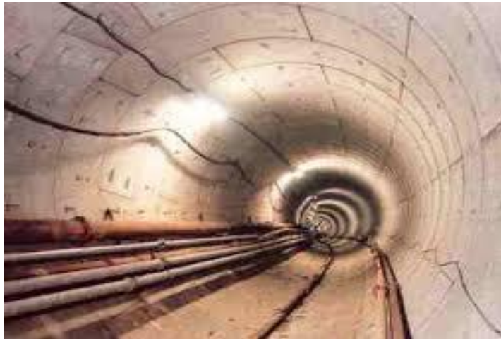
Figure II.17 : revêtement par voussoirs en béton .
