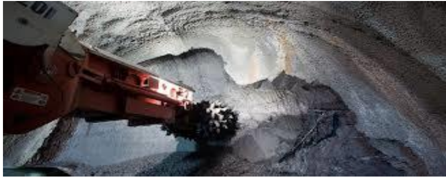
Figure II.3 :Machine à attaque ponctuelle .
