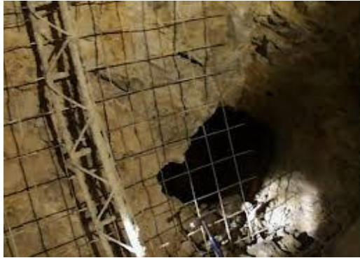
Figure II.13 : cintre réticulé
