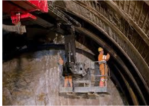
Figure II.14 : mise en place du cintre
