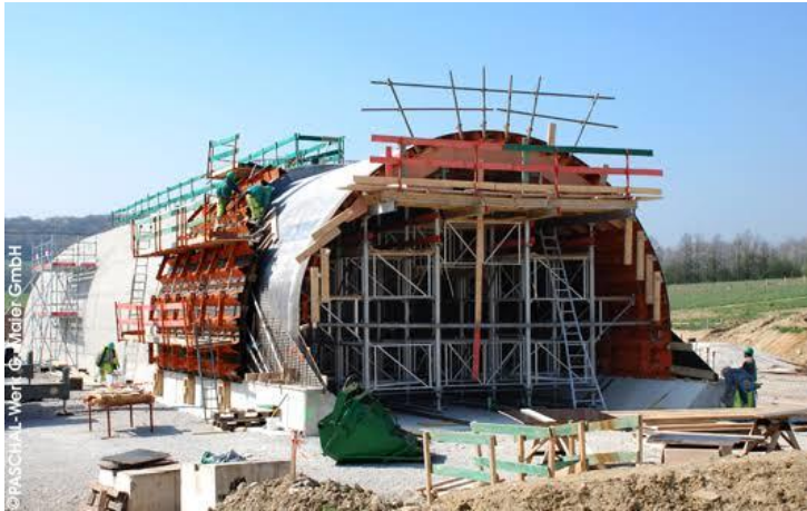
Figure II.19 : exemple de coffrage de tunnel .
