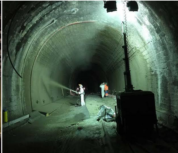
Figure II.6 : Béton projeté avec les cintres
