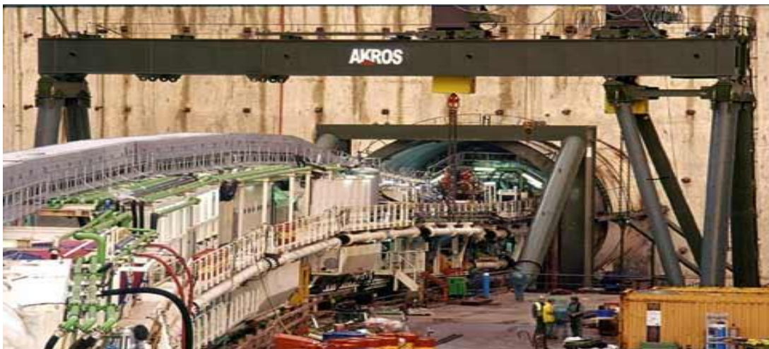
Figure. I.5 : Montage du tunnelier Est pour le percement du tunnel de l'A86 Ouest, long de 10 km.
