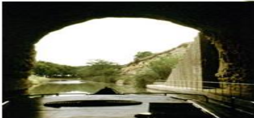
Figure. I.4 : Canal du Midi sorties Est et Ouest du tunnel de Malpas
