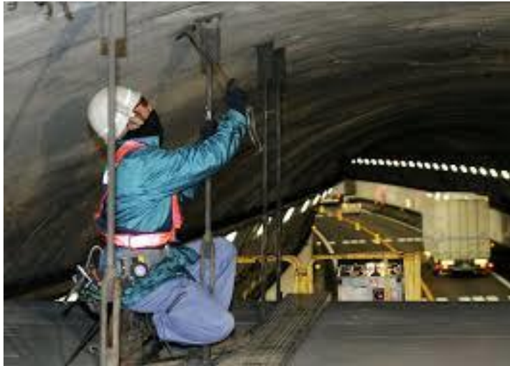
Figure II.7 : boulons à encrage
