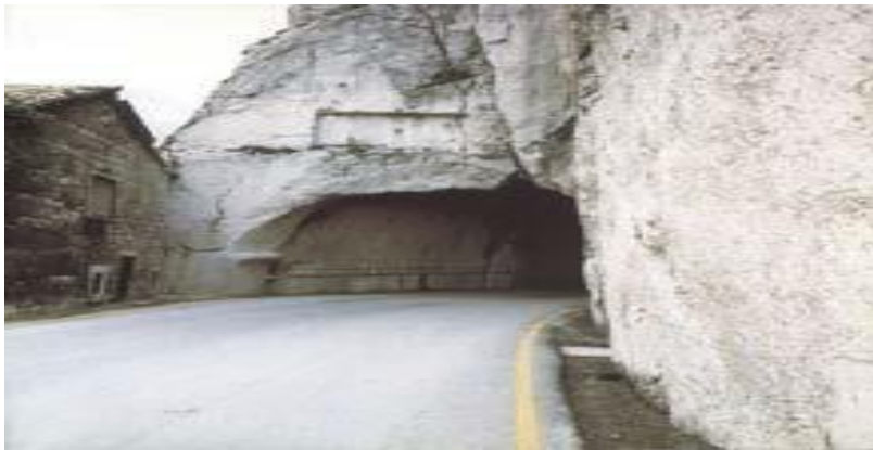
Figure I.2 Le tunnel de la Traversâtes, au Mont Viso.
