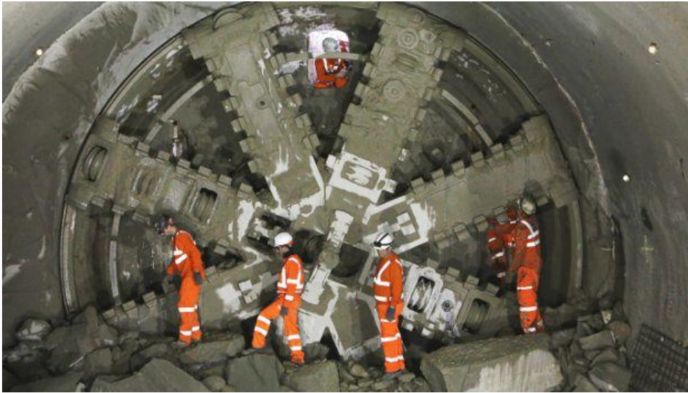
Figure II.4 : Creusement au tunnelier
