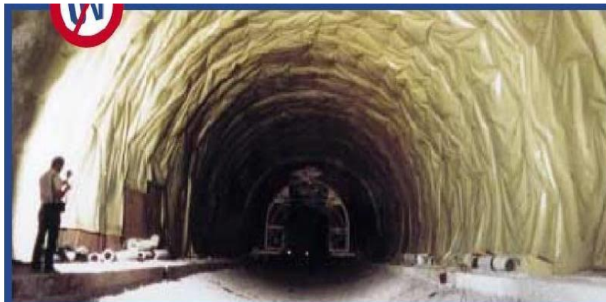
Figure II.21 : Etanchéité par Géo membrane
