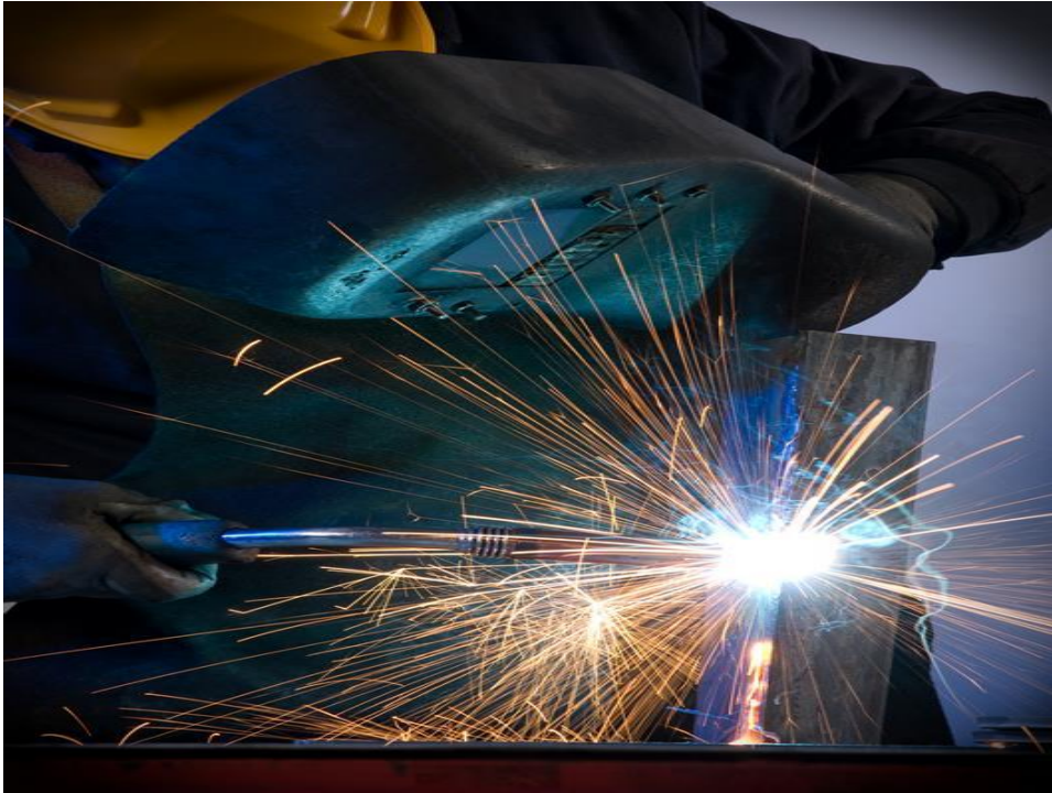
Fig.1.11. L'opération de soudage.
