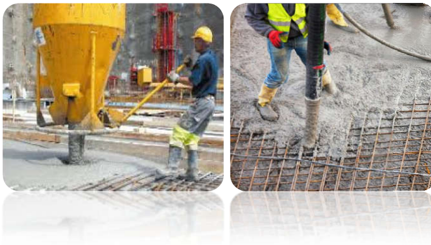
Figure I. 3 : Mise en place du BAP par un seul ouvrier.
