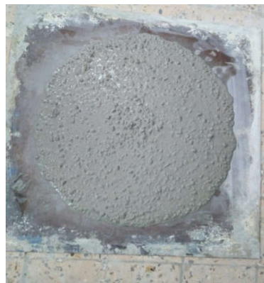
BAP T (1m 3 ) après Correction du dosage en SP de 1% à 1,1%
