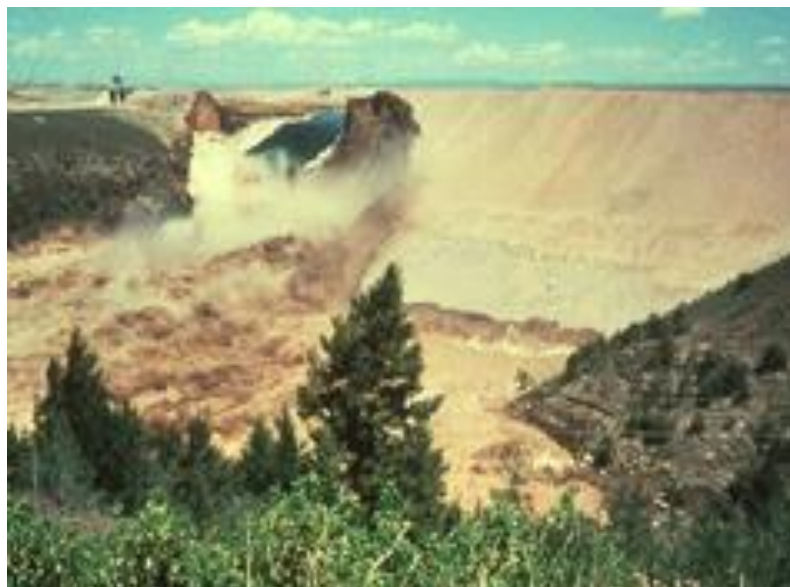
Figure II barrage de TETON après la rupture
