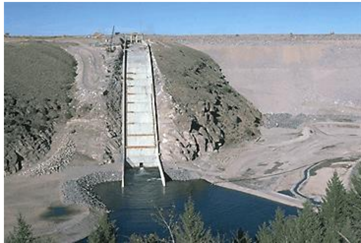
Figure I barrage de TETON avant rupture
