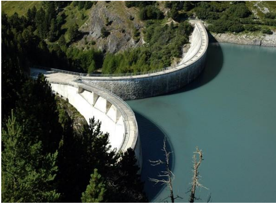
Figure VI : barrage-voute Aussois, Savoie, Rhône alpes
