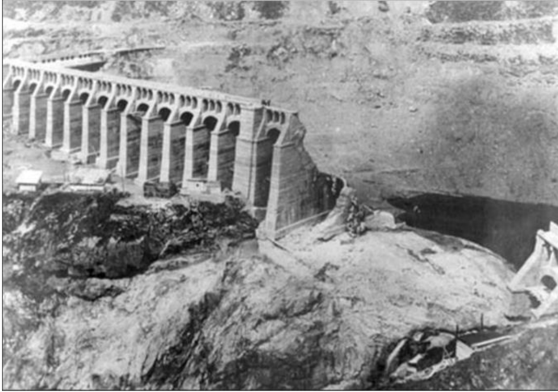
Figure VII : barrage de GLENO après la rupture
