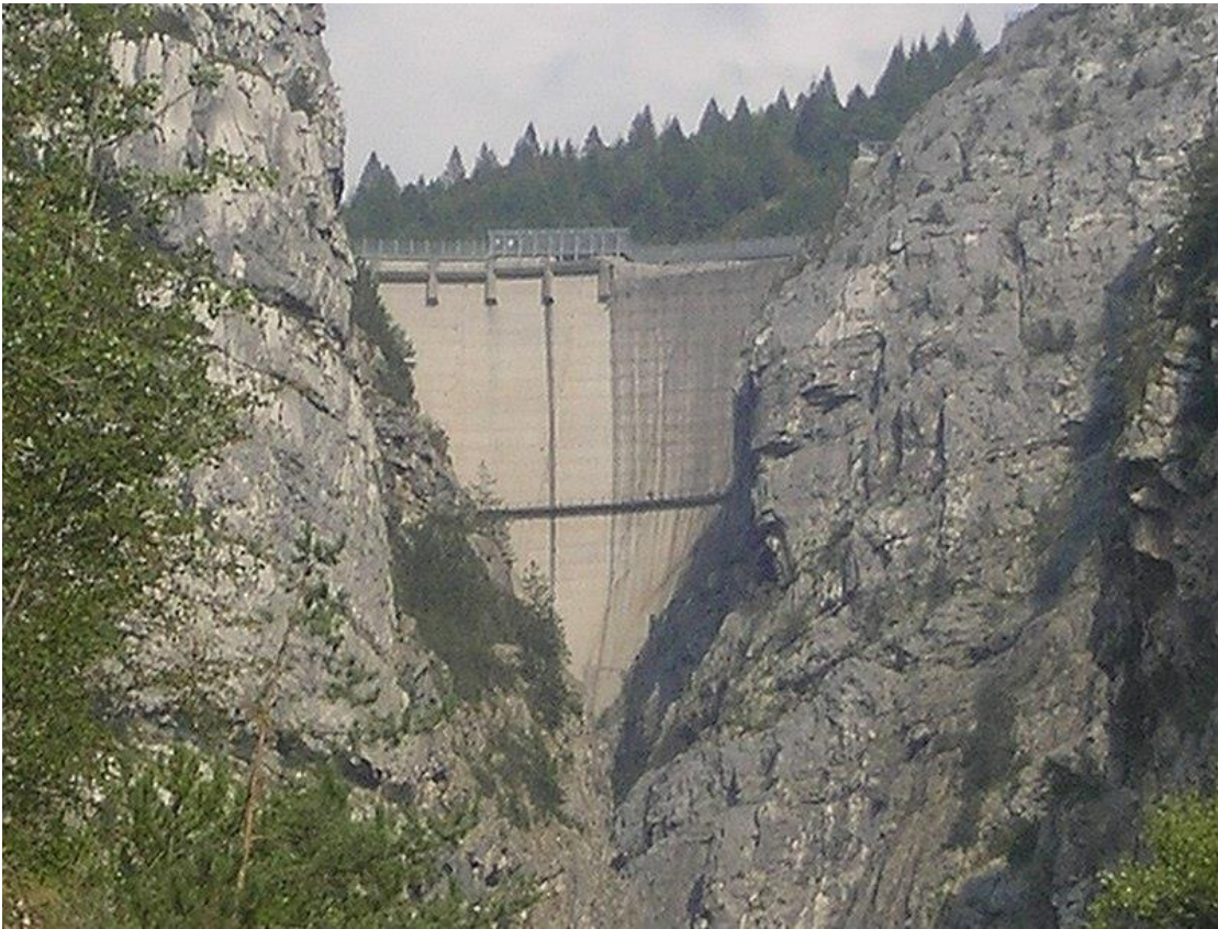
Figure VIII : barrage de VAJONT avant la rupture
