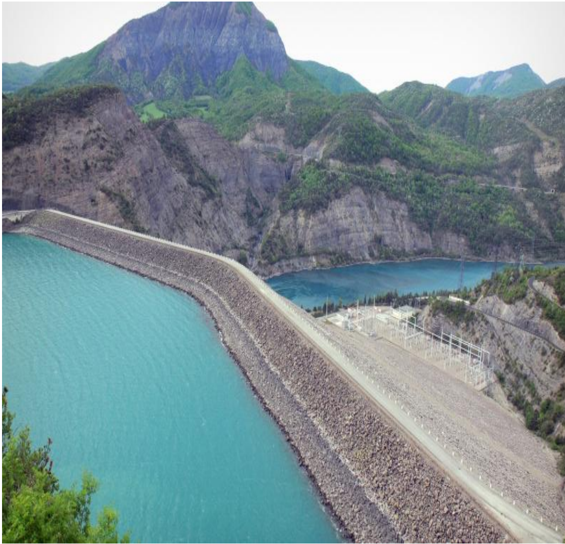
Figure XIII : Barrage zoné à noyau étanche serre ponçons hautes alpes
