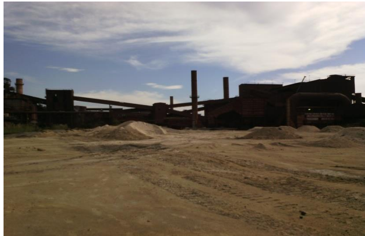
Figure 2.6 Laitier des hauts fourneaux d'EL HADJAR sur le site.
