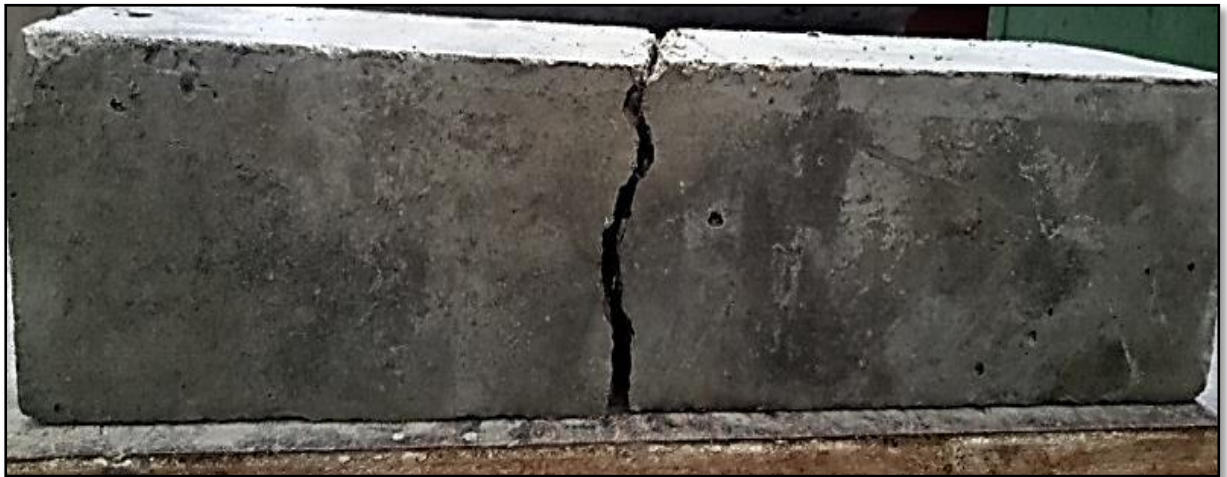
Figure III.13: Rupture inclinée à droite.
