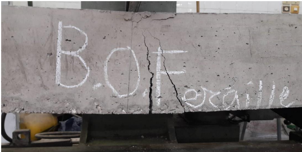
Figure III 15 Mode de fissuration de La poutre en béton Armé fissuré
