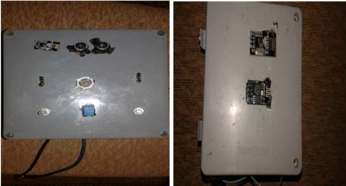
Figure II.16: Installation des capteurs dans le nœud capteur et nœud passerelle.
