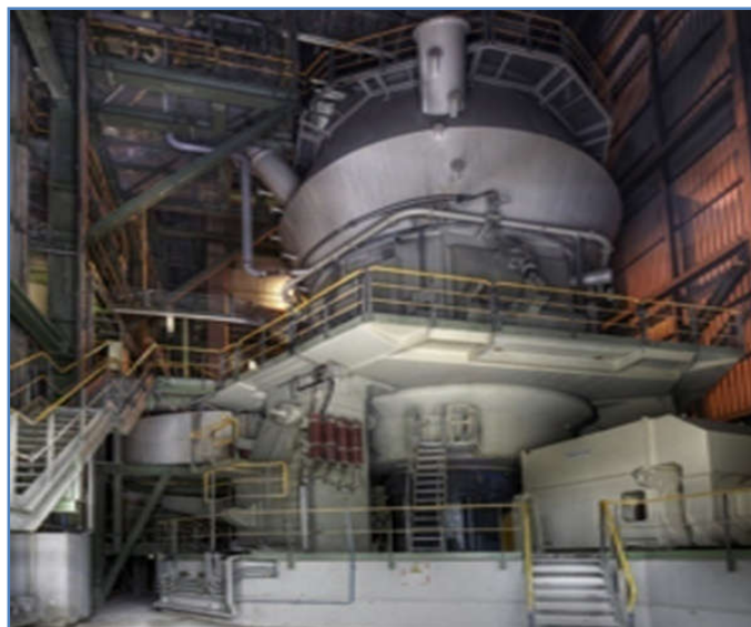
Figure 1.4 : Four de cimenterie.
