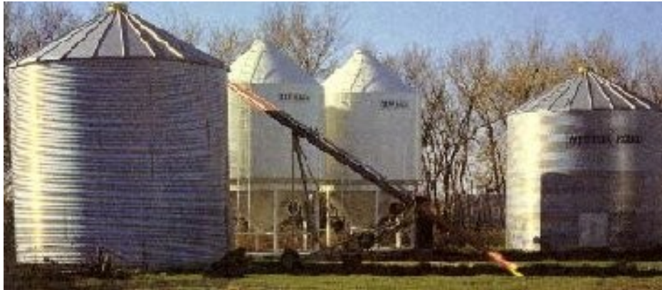
Figure1: Silos de stockage des grains [20].
