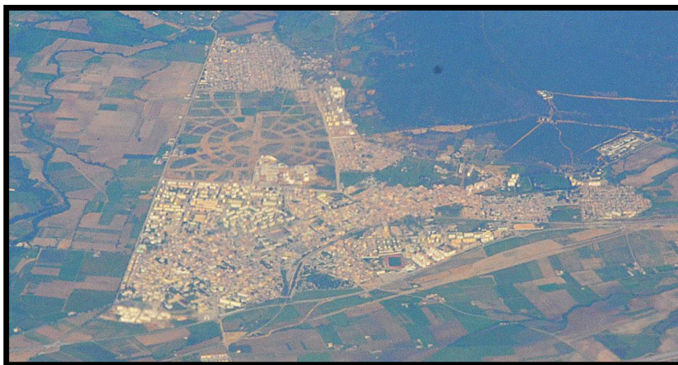
Figure III.1. Vue aérienne de la ville d'Azzaba
