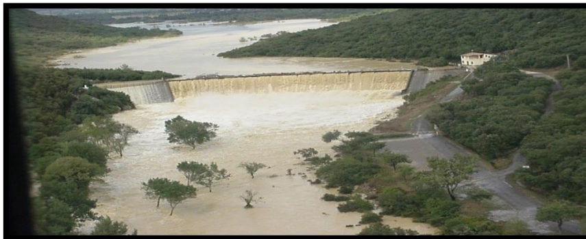
Figure I.7. Inondations par rupture d'ouvrage ou d'embâcle
