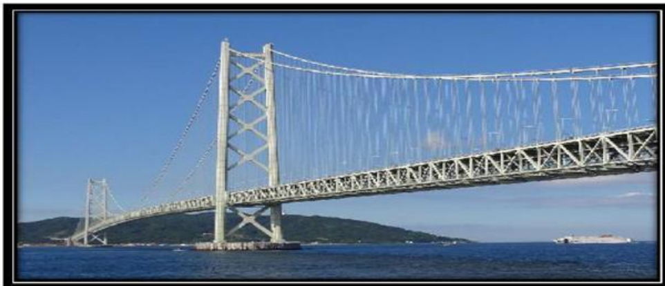
Figure I.1.1 : Le pont Akashi Kkaikyo
