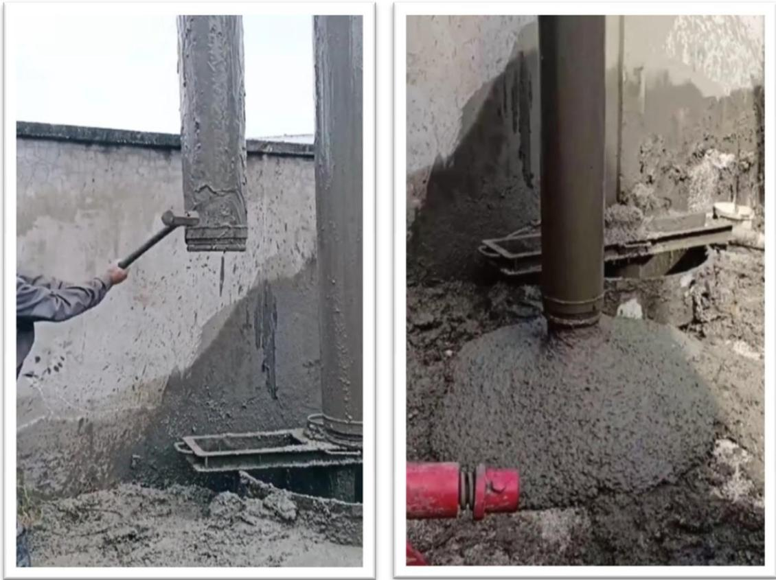
Figures 4.73 – Débouchage des tubes plongeurs
