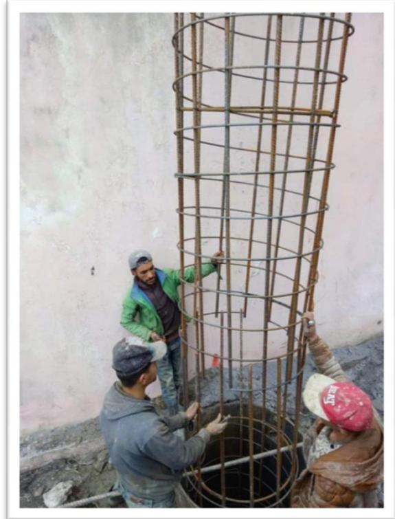
**Figure 5.28 – Mise en place des cages d'armatures**
