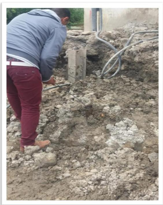
Figure 4.67 - Remplissage des tubes avec de l'eau
