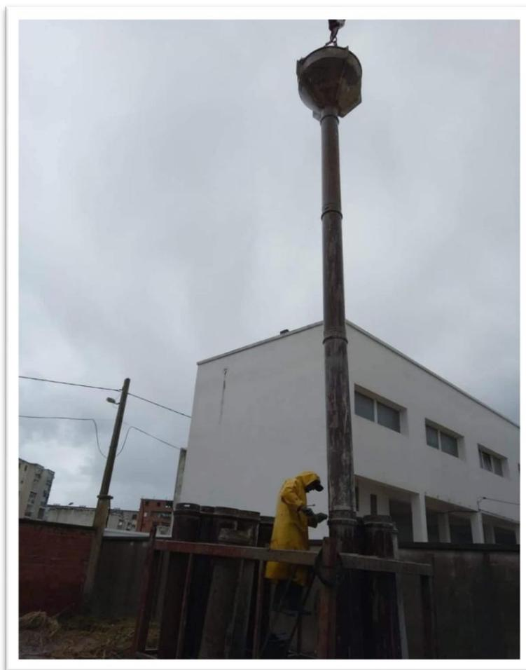
Figure 4.42 – Emboitement des tubes plongeurs
