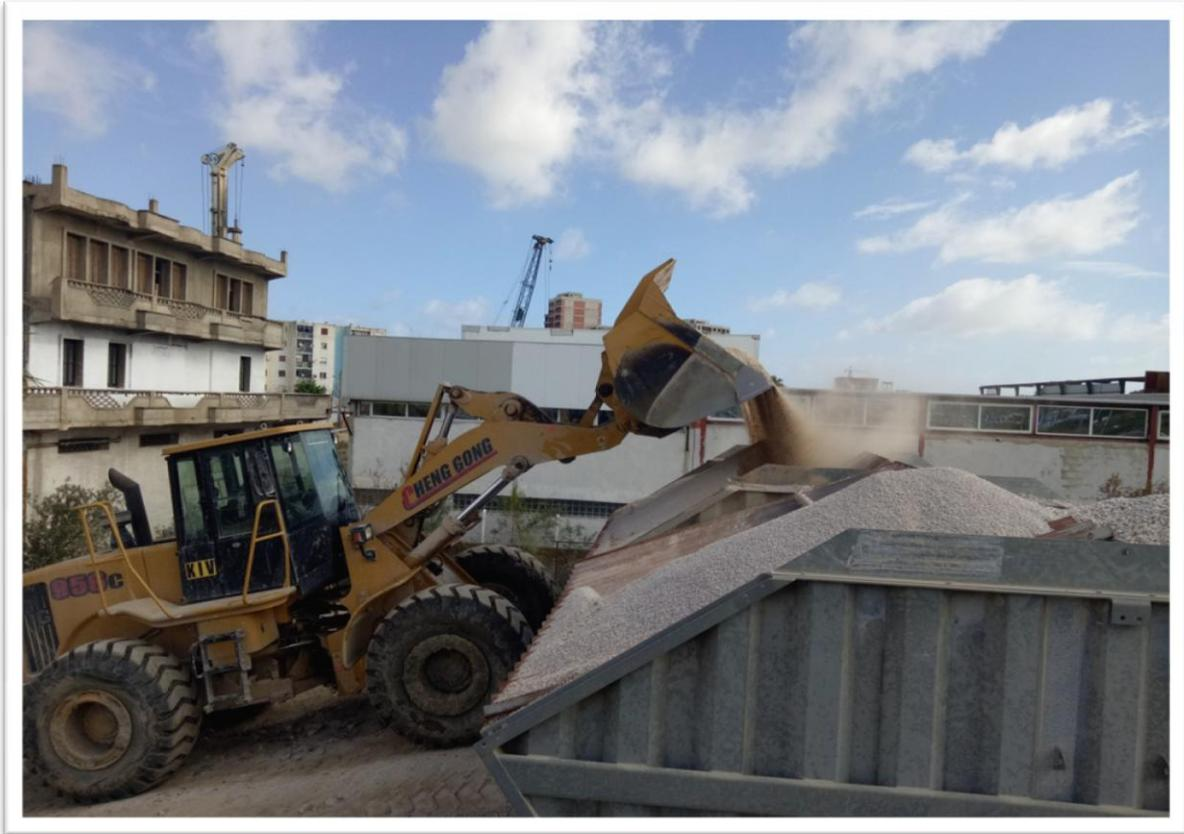
Figure 4.35 – Chargement des agrégats dans les bacs de la centrale
