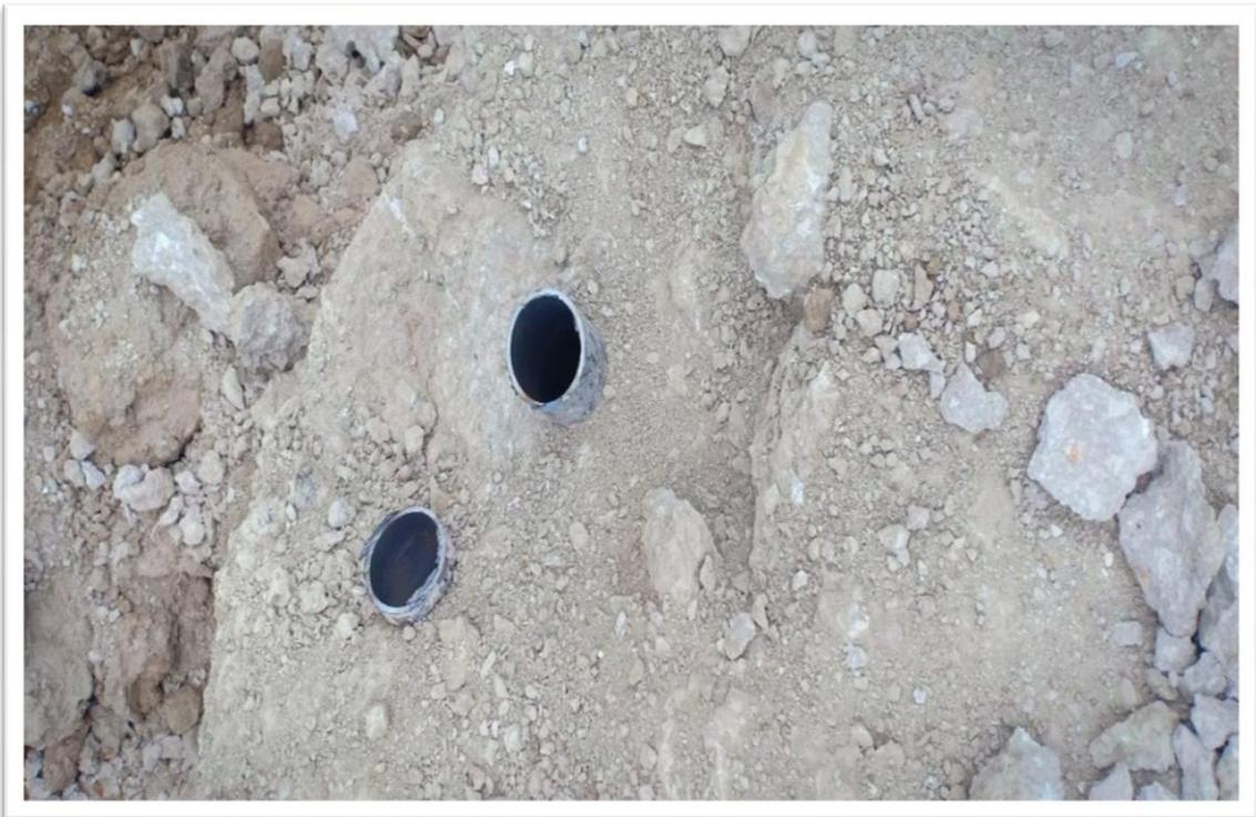
Figure 4.65 – Préparation des tubes soniques à la réception des sondes
