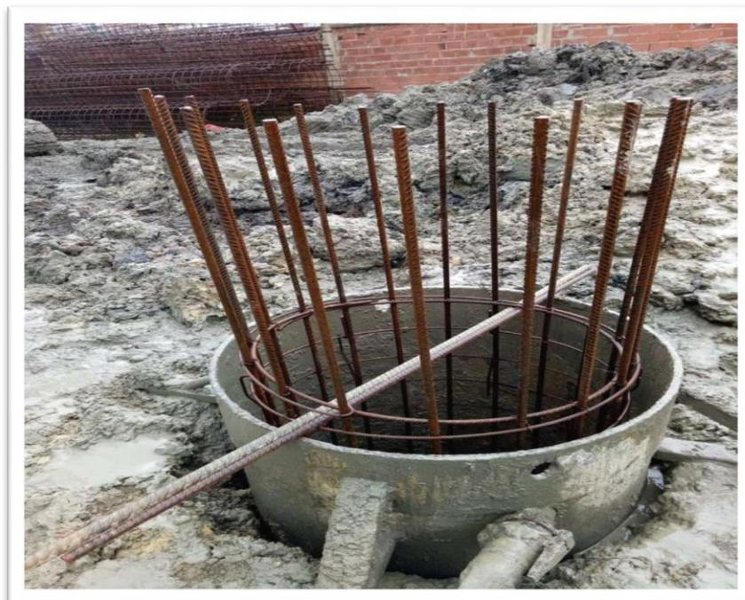
Figure 4.32 – Mise en place des cages d’armatures dans le forage
