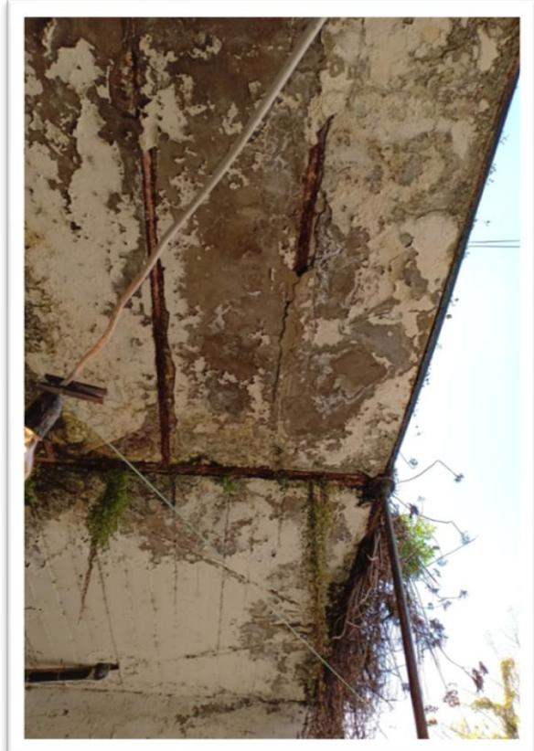
Figure 6.15 - état de la dalle pleine corrosion avancée
