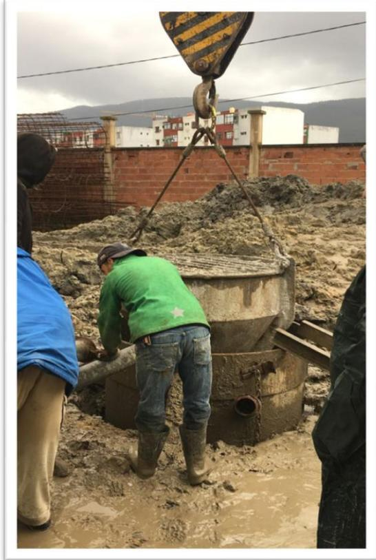
Figures 4.45 – Mise en place de l'entonnoir à béton
