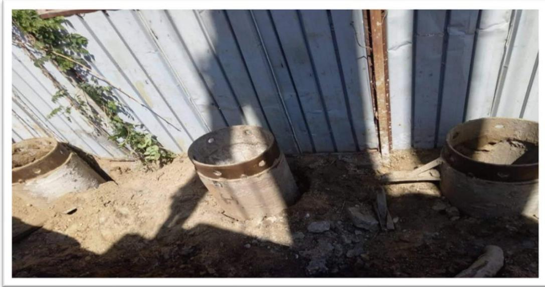
**Figure 5.31 – Pose des viroles pour le forage de la paroi berlinoise**
