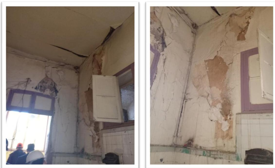
Figures 6.07 - Murs intérieurs en plâtre dégradés par l'eau
