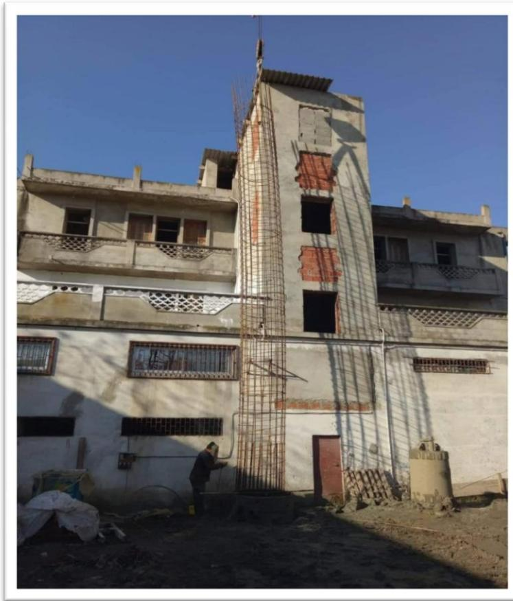
Figure 4.31 – Assemblage de deux cages d’armatures par recouvrement
