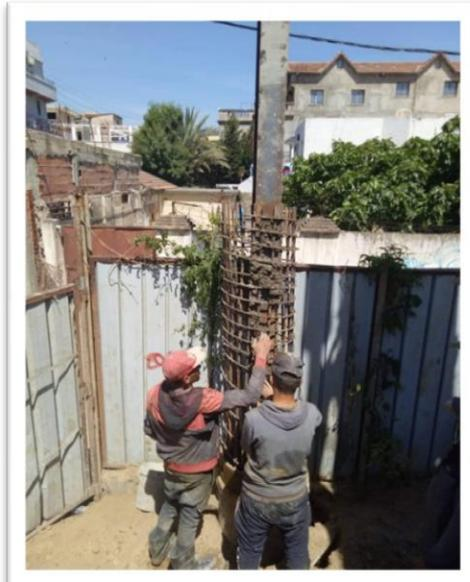
**Figure 5.33 – Mise en place du ferrailage**
