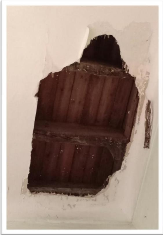
Figure 6.11 - Plafond en bois et faux plafond en placoplâtre
