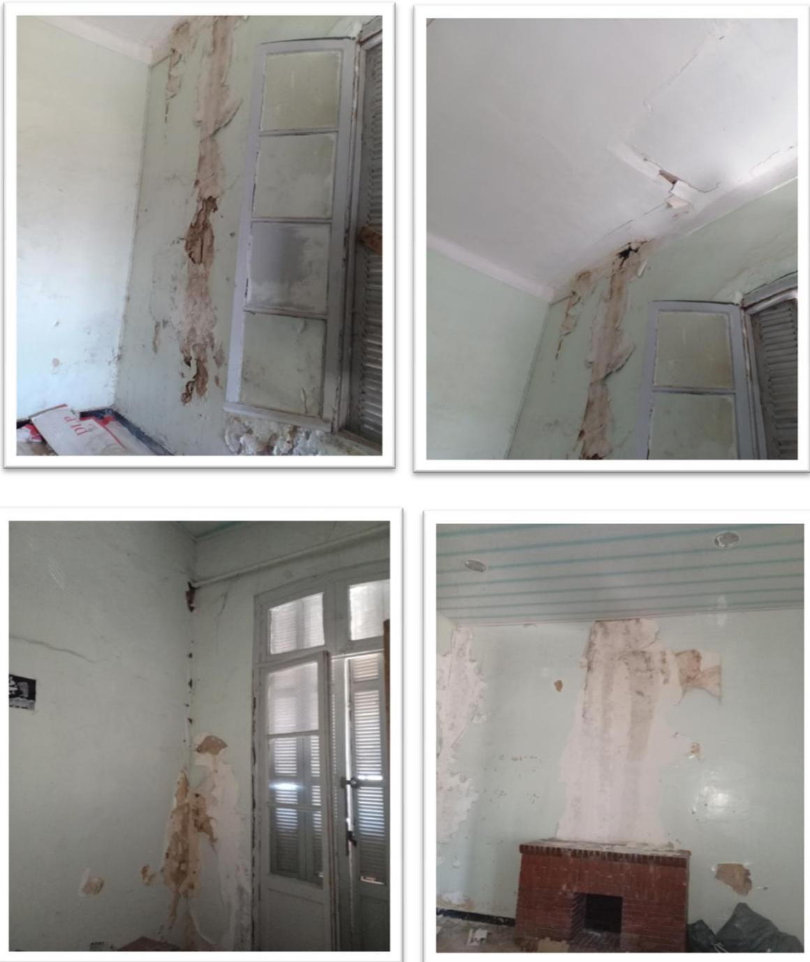
**Figures 6.06 - Murs intérieurs fissurés et dégradés par l'infiltration d'eau**
