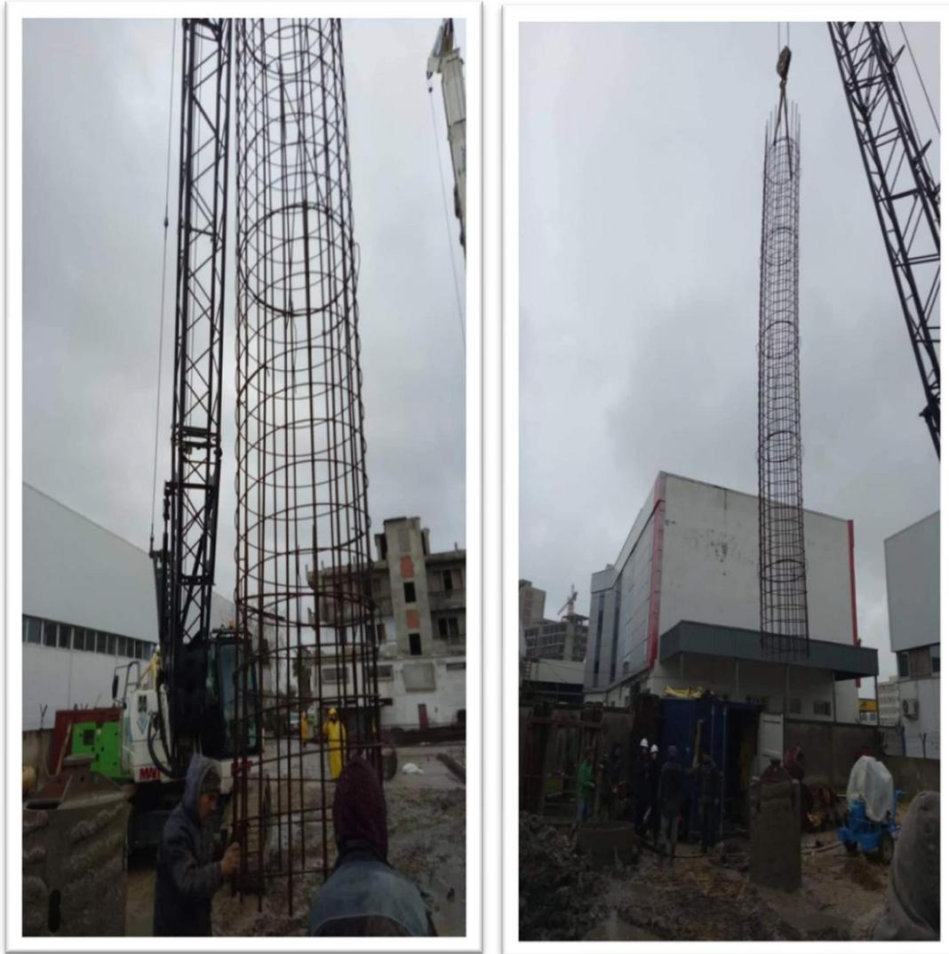
Figures 4.30 – Transport d'une cage d'armature à l'aide d'une grue sur chenille
