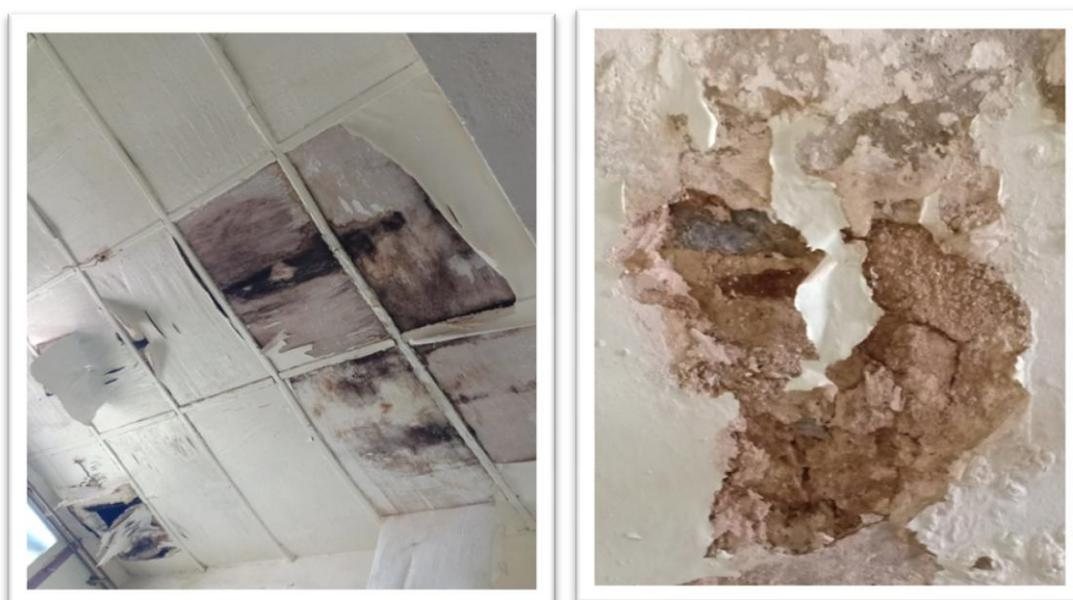
Figure 6.08 - Toiture en bois dégradé et fléchi avec infiltration d'eau pluviale
