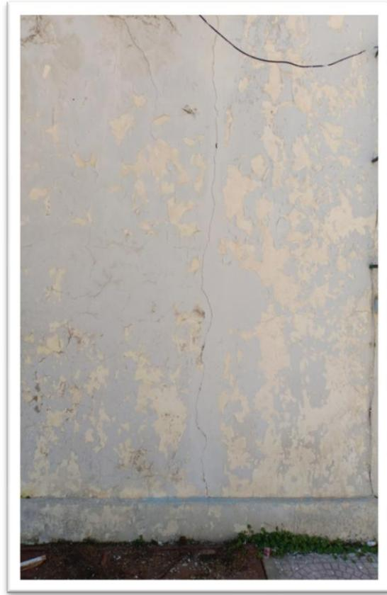
**Figure 6.03 - Mur extérieur fissuré**
