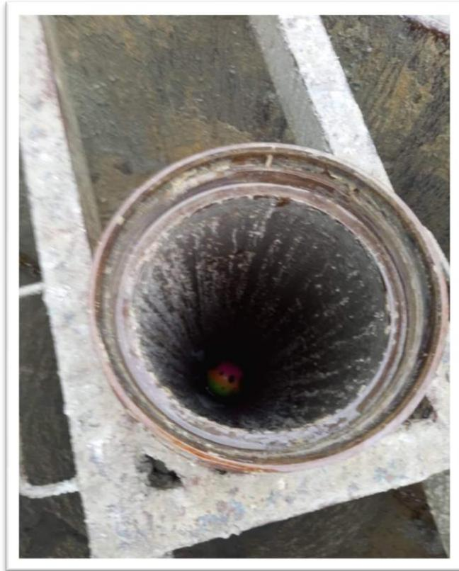
Figure 4.43 – Ballon à l'extrémité du tube
