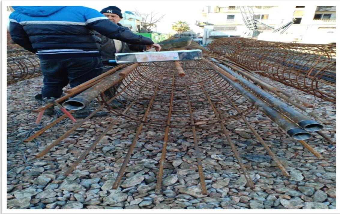
Figure 4.64 - Mise en place des tubes soniques sur la cage d'armatures
