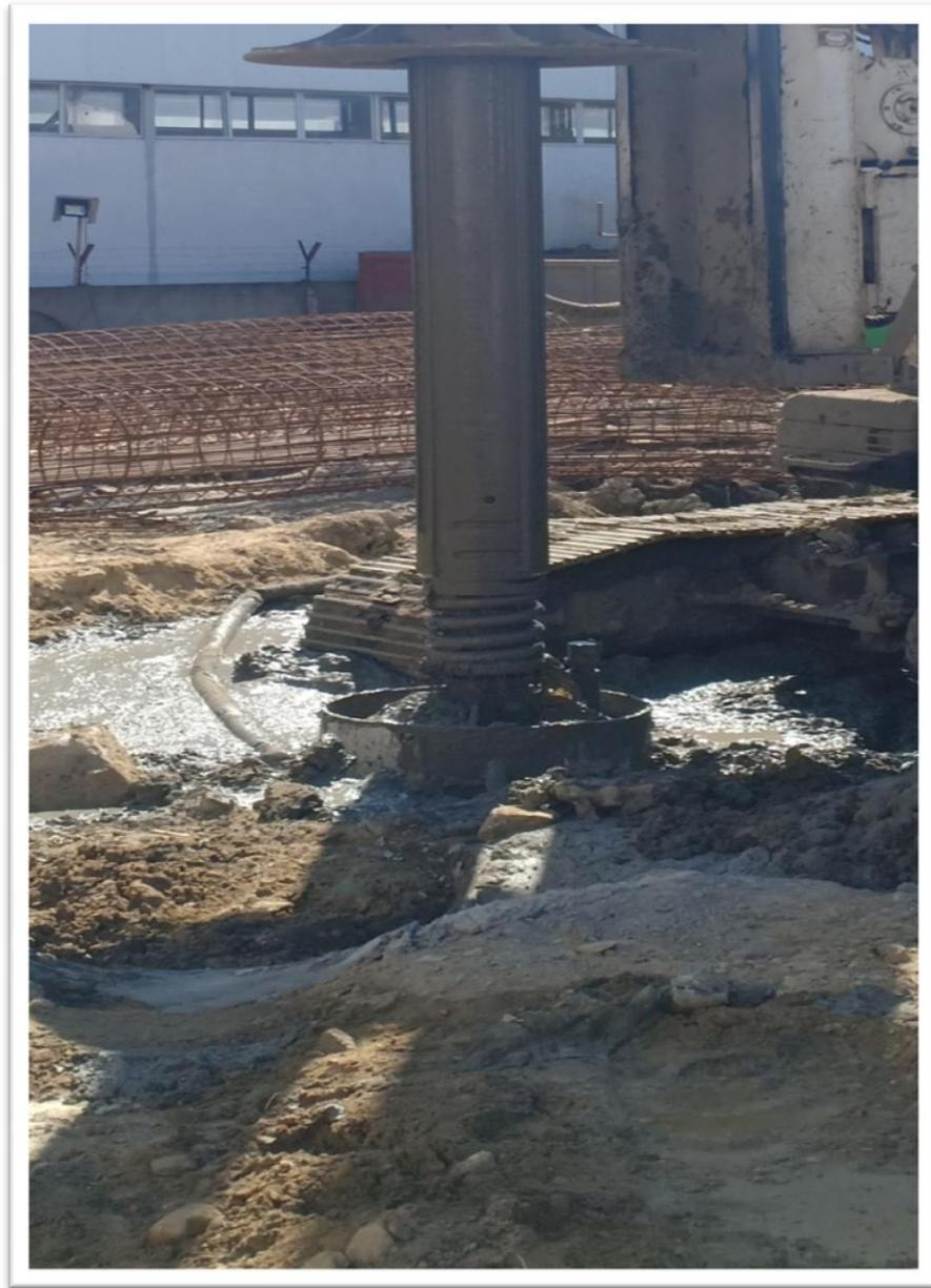
Figure 4.20 - Forage d'un pieu avec une bucket argile
