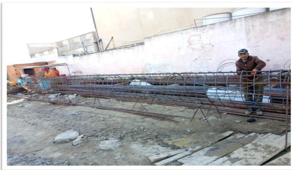
**Figure 4.28 – Façonnage cage d'armatures**
