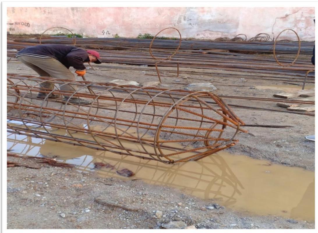
**Figure 5.24 – Cage d'armatures**
