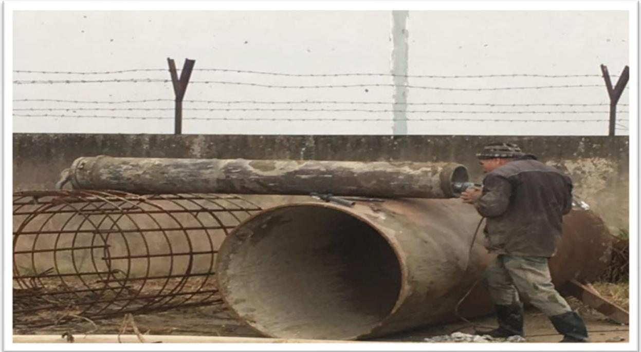
Figure 4.41 – Préparation des tubes plongeurs
