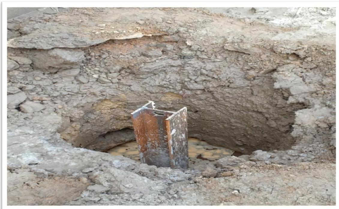
Figure 4.57 – Mise en place d'un profilé métallique H
