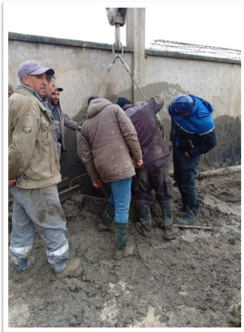
**Figure 4.72 – Bouchage des tubes plongeurs**
