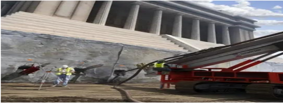
Figure3.4 : tirant d'ancrages
