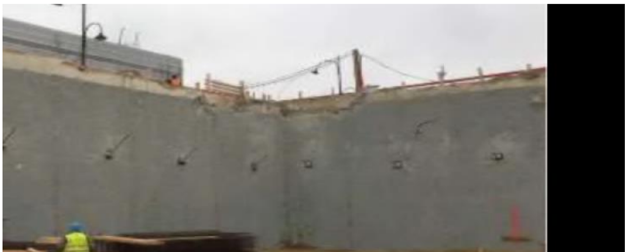
Figure2.1 Photo de la paroi moulée
