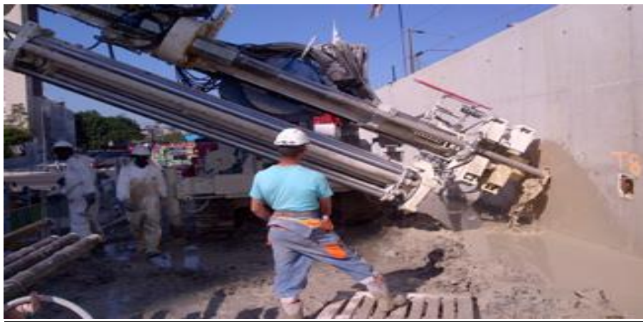
Figure3.14 : image de forage
