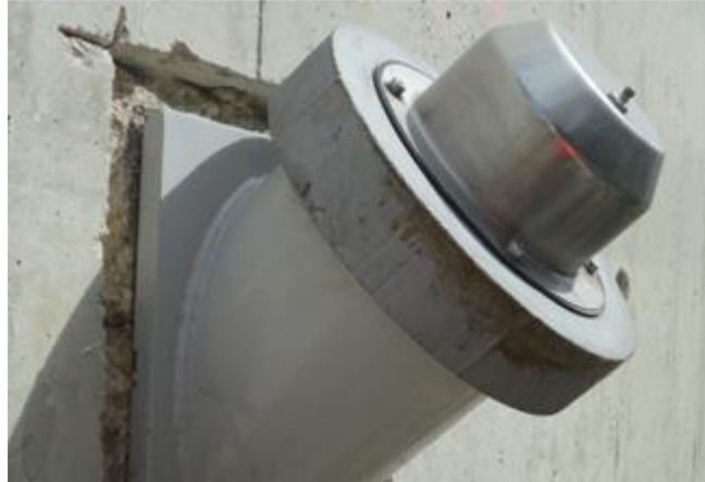
Figure3.18 : image de la tête d'ancrage
