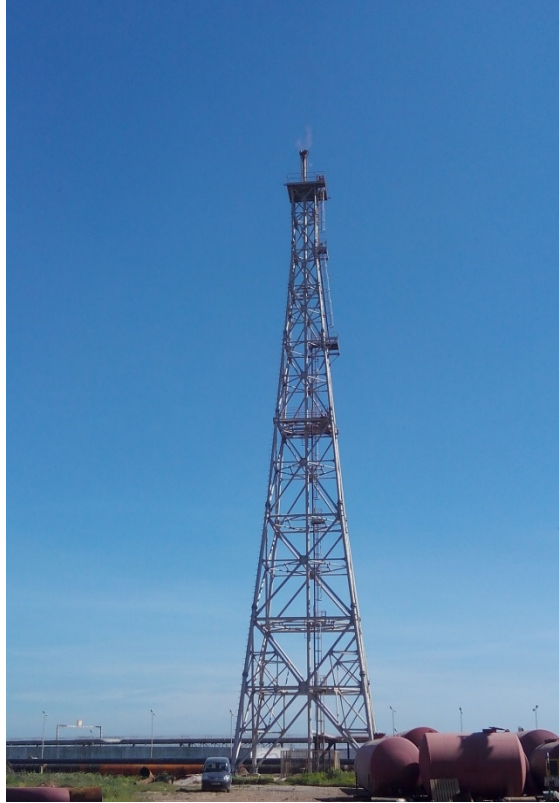
Figure.III.9 La torchère de secours
