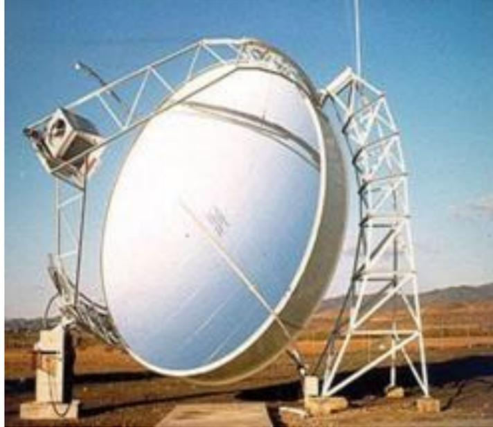
*Figure III.13: Concentrateur parabolique avec moteur Stirling*
