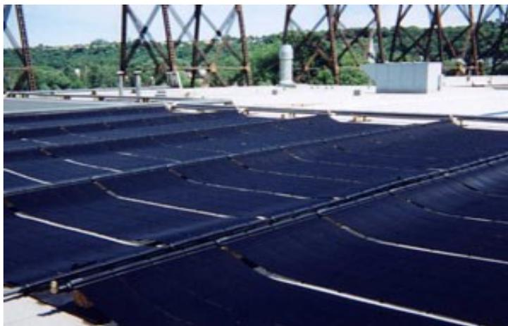
**Figure II. 1** : Capteur plan sans vitrage
