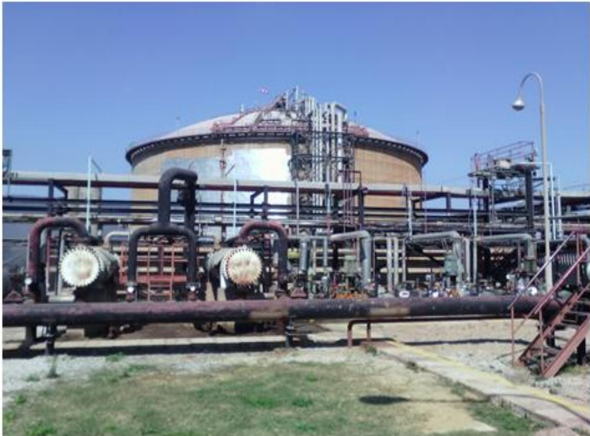
**Figure3.1.réservoir à toit fixe (bac de stockage des produits énergétiques)**
