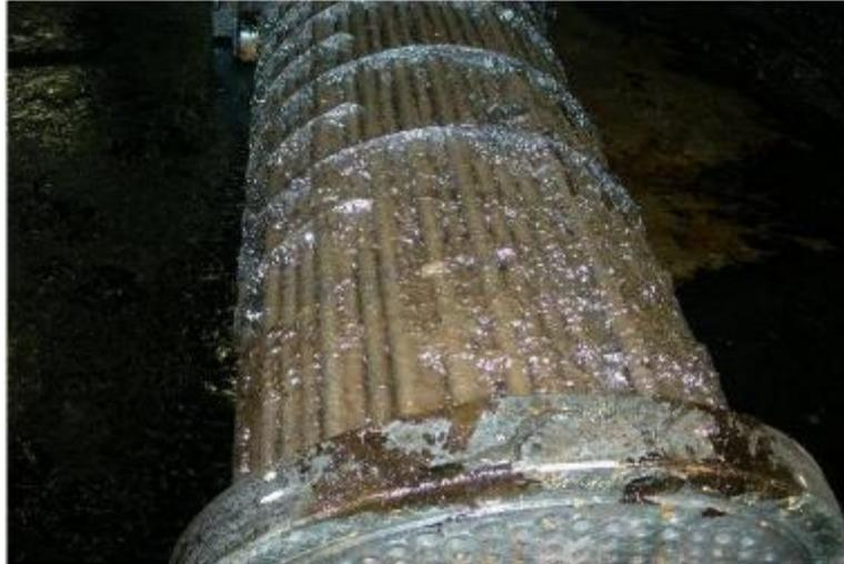
**Figure 9** : Exemple d'un faisceau de tubes d'un échangeur encrassé
