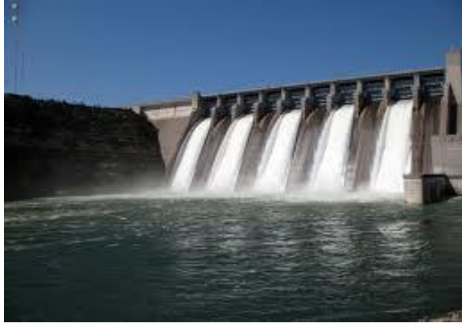
Figure III.23 : Centrale Hydroélectrique de moyenne chute
