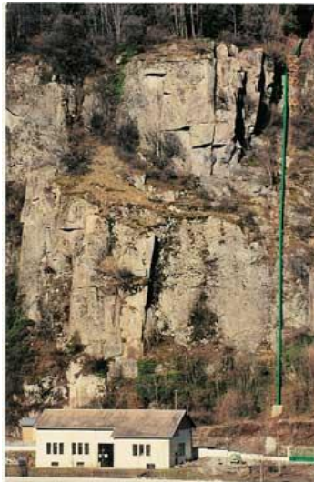
Figure III.24 : Centrale Hydroélectrique de haute chute
