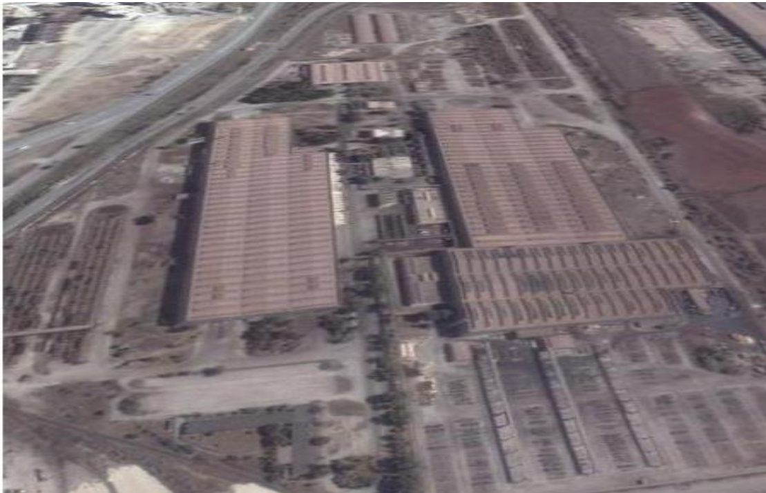
Figure 2 : Vue générale de la TSS
