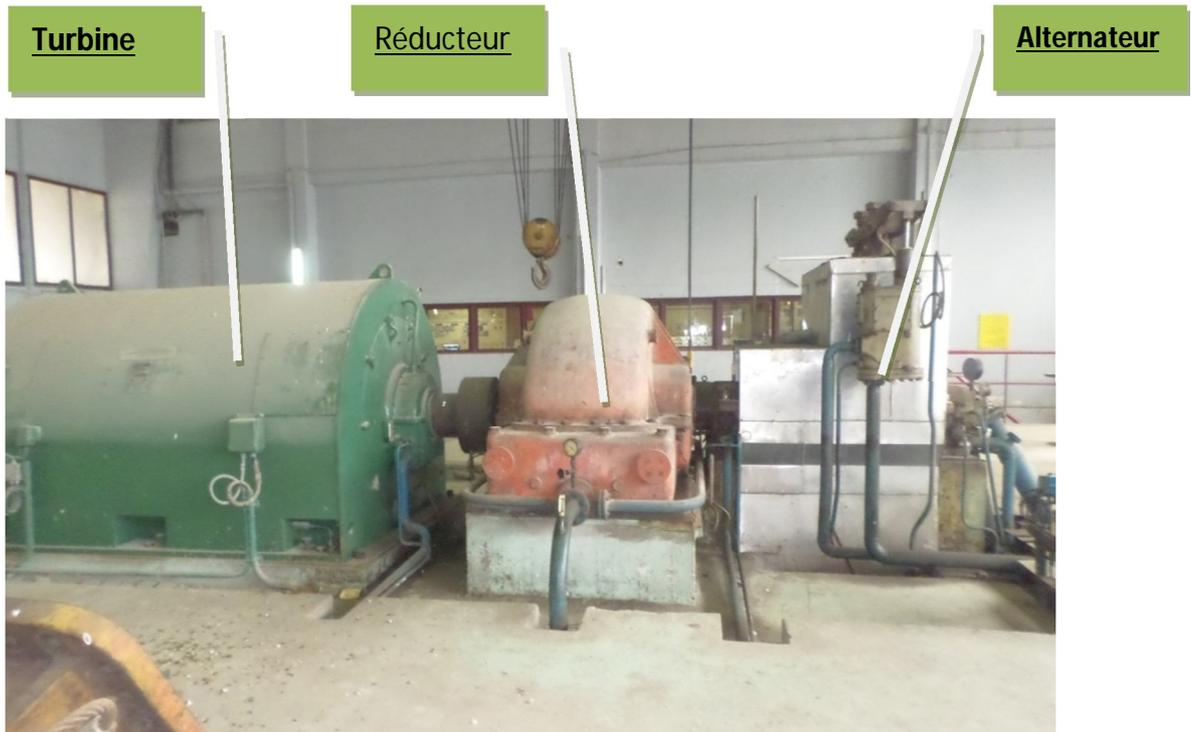
**Figure 2 : Turbo-alternateur (10 MVA)**
