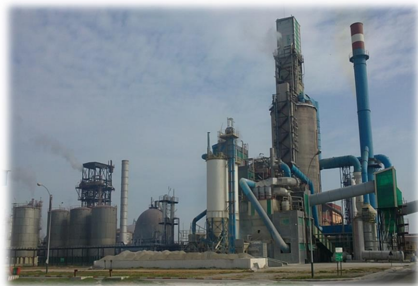
Figure II.5: Vue générale sur l'unité d'ammoniac.
