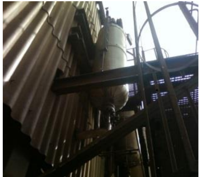
Figure III.17 : réservoir de retour d'huile HB et BP
