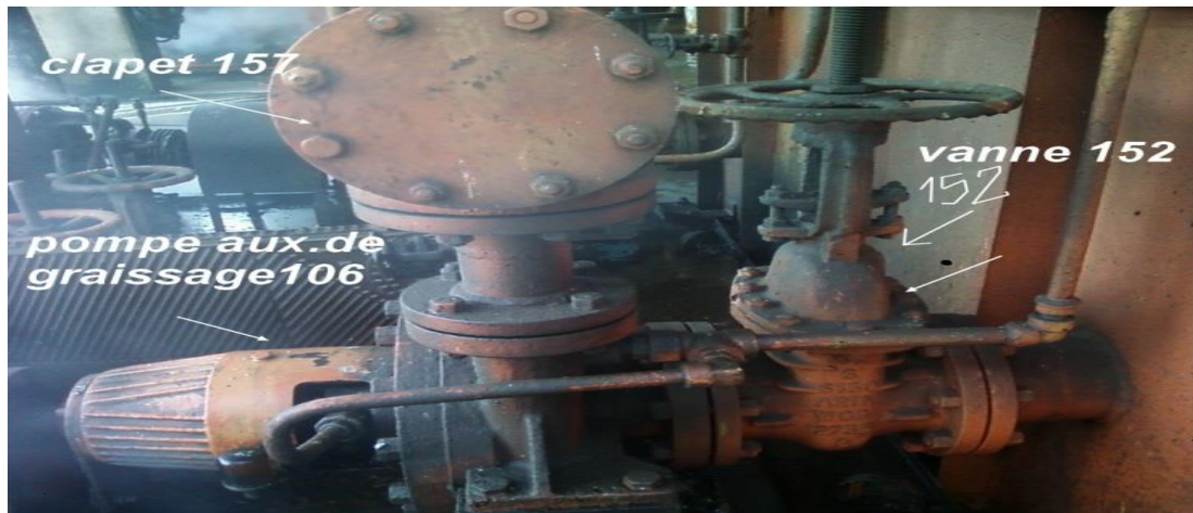
Figure III.12: pompe d'huile auxiliaire
