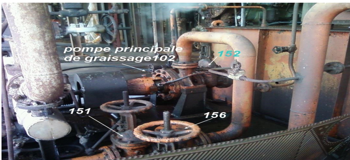
Figure III.11 : pompe d'huile principale
