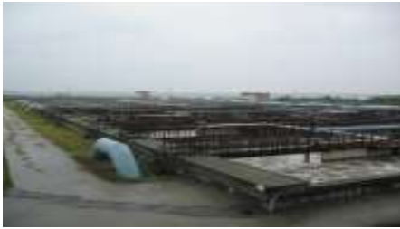
Fig.II.11 : Ventilateur de traitement des eaux
