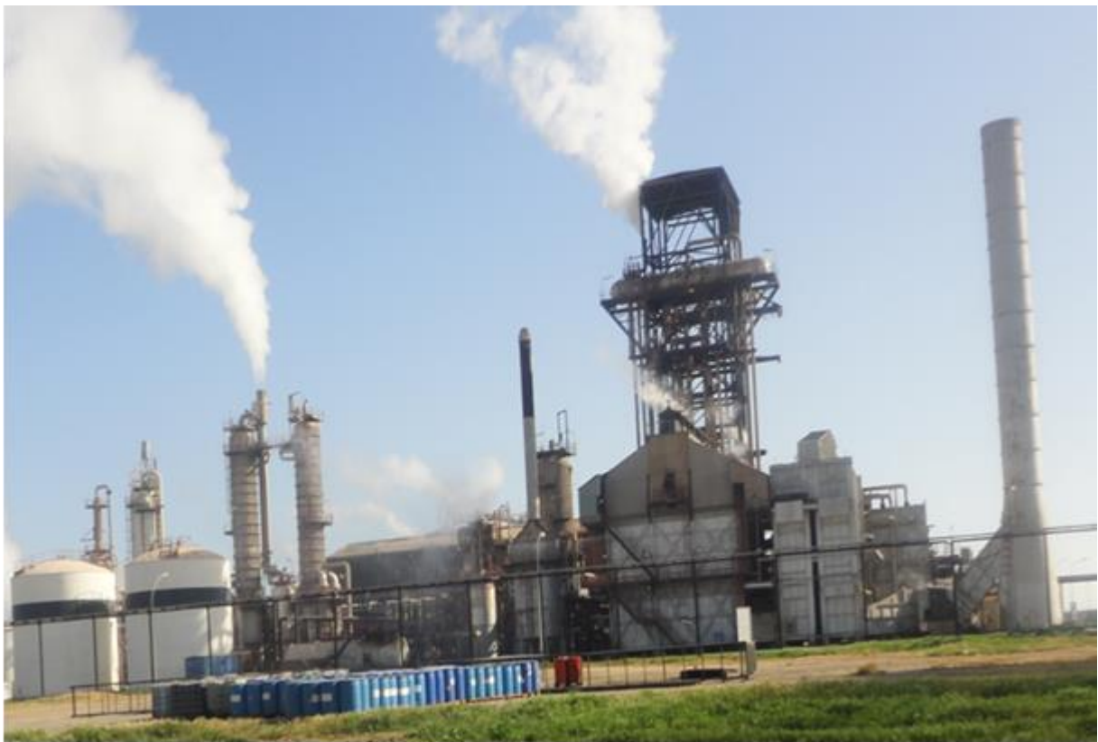
Figure I.4 : Vue générale sur l'unité d'ammoniac.
