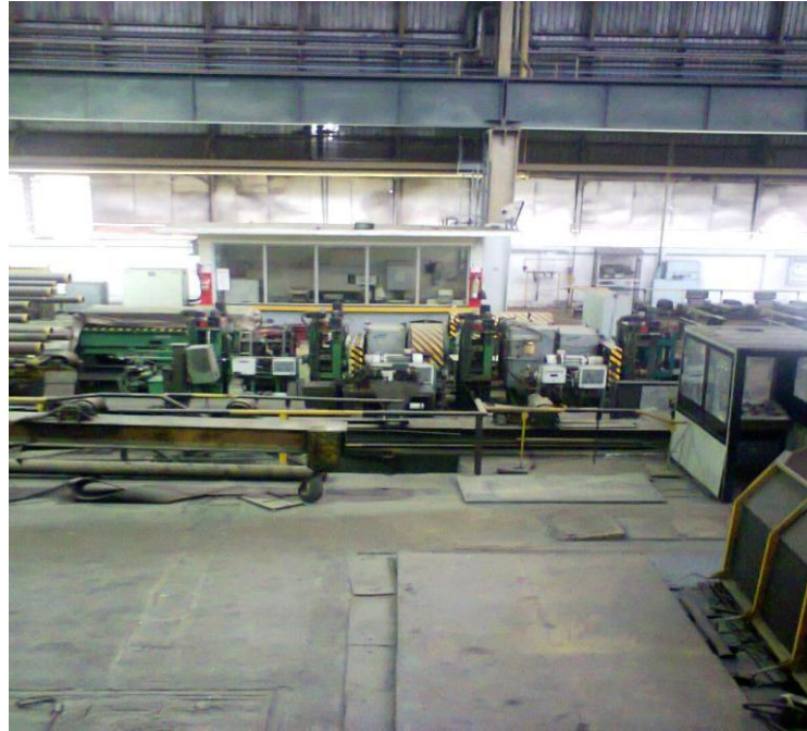
Figure N° 14: Contrôle CND (Contrôle Non Destructif)
