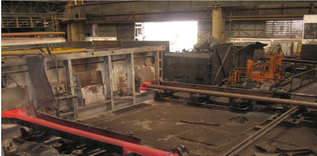
Figure N° 11: Four à longerons avant calibreur
