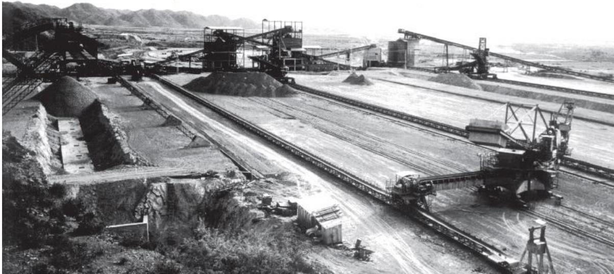
**Figure 7 : Convoyeurs de carrière**
