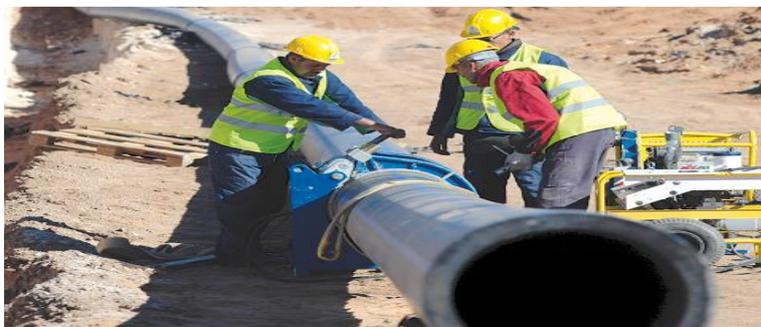
*Figure I.3 : Tube d'eau potable (Marqu  en bleu)*
